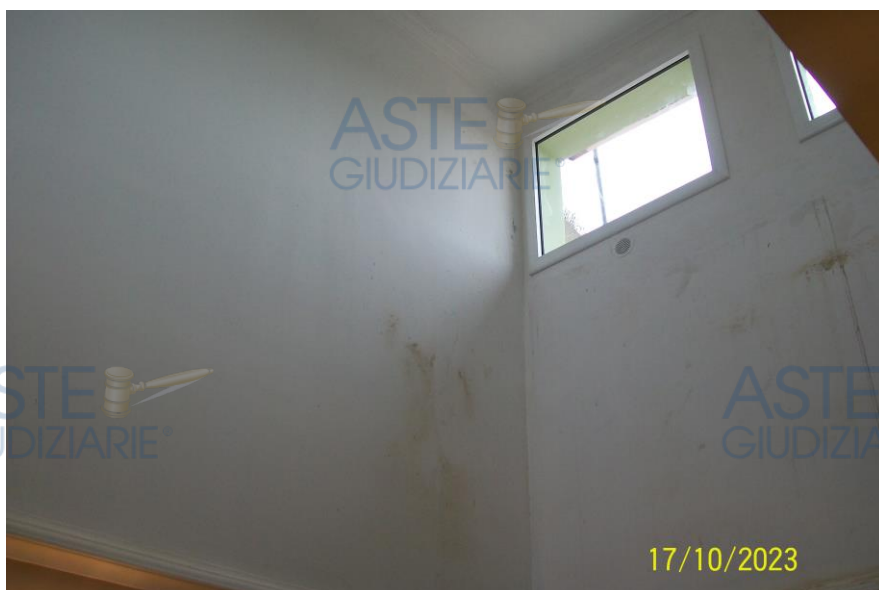
Tracce di condensa sulle pareti del vano scala del secondo piano
