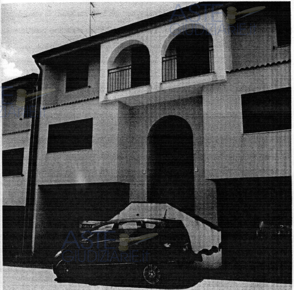
Fig. 4. Prospetto nord con particolare dell'accesso all'appartamento oggetto della proc. n. 30/2011 R.G. Es.
