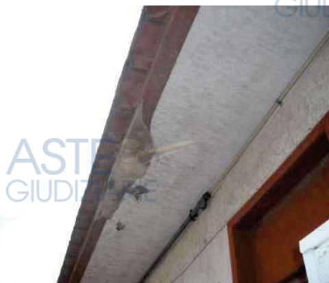
Balcone sul prospetto di via Veneto e pensilina superiore con distacco di intonaco
