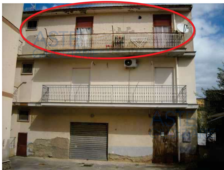
Esterno del fabbricato condominiale. E' evidenziato il subalterno 12
