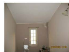
30-vano scala P2°
