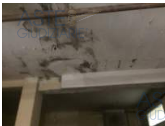
Interno del locale magazzino. Sono visibili i danni da infiltrazione d'acqua dai piani superiori.
