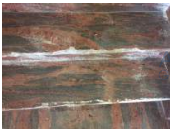
Segni di risalita di umidità dal basso che ha danneggiato la pavimentazione e le pareti del vano scala condominiale
