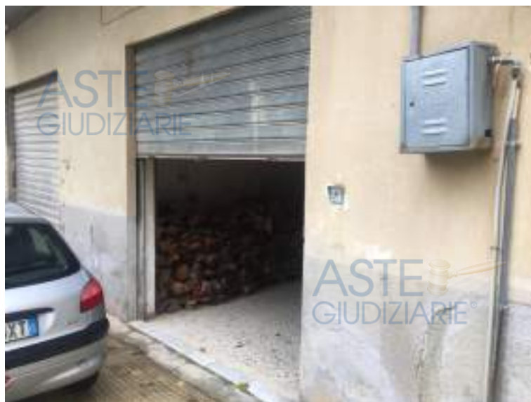
Prospetto del locale garage con infisso di ingresso a saracinesca
