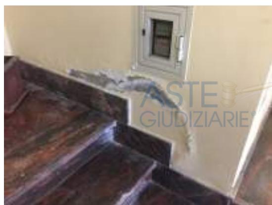
Segni di risalita di umidità dal basso che ha danneggiato la pavimentazione e le pareti del vano scala condominiale
