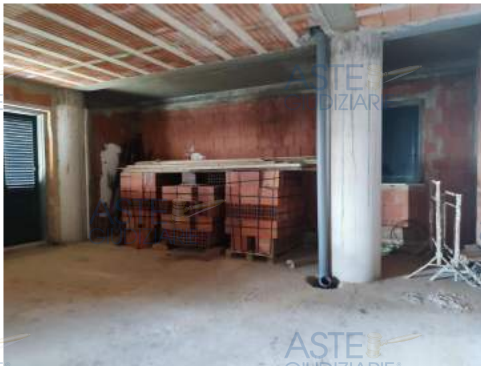
SUB 43 parte angolare del bene, su due affacci: Sud-Ovest e Nord-Ovest .
