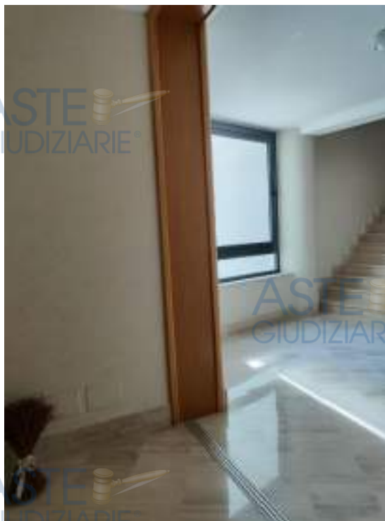
Particolare del pianerotto del piano Primo sulla parete e sul pavimento giunto di dilatazione tra I due corpi di fabbrica di cui è composto il fabbricato
