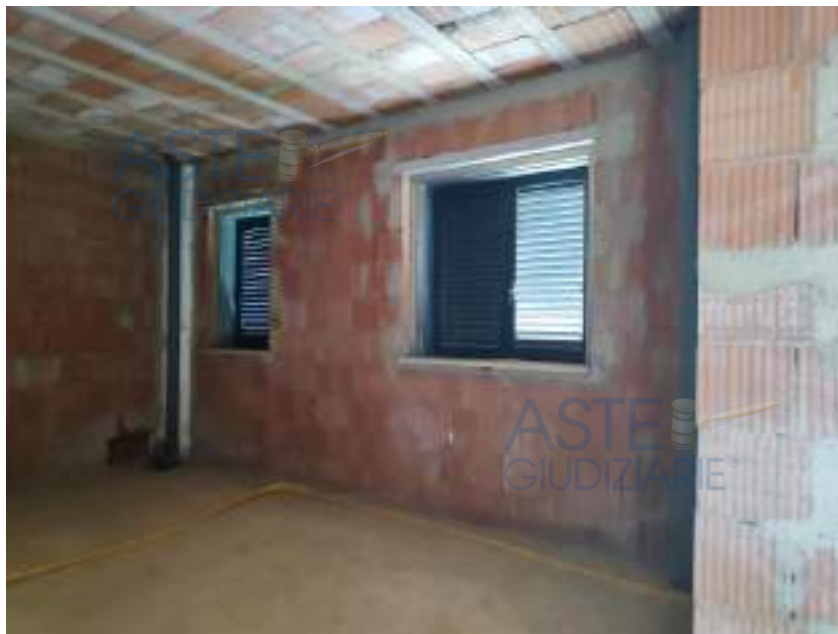
Infissi prospicienti il lato Sud-Est del Fabbricato.
