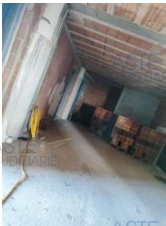
SUB 42. Pancali in prossimità della parete esterna del vano ascensore in c.c.a.
