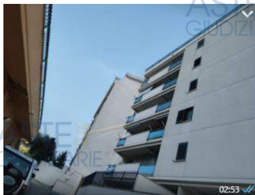
Prospetto del fabbricato a monte del sito.
