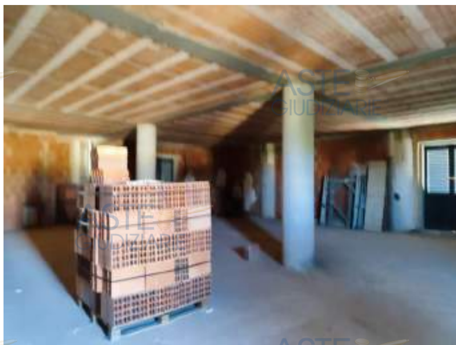
L'ambiente unico dei due subalterni 42/43 si presenta allo stato grezzo, presenti i pancali con i laterizi.
