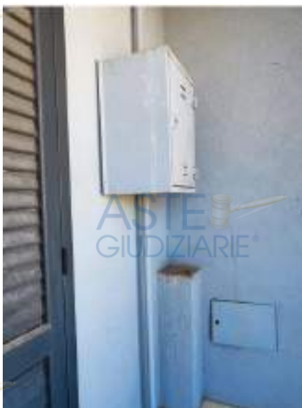
CASSETTA PER IL CONTENIMENTO DEL CONTATORE DEL GAS E DELL'ACQUA. PREDISPOSIZIONE DELLA CALDAIA.
