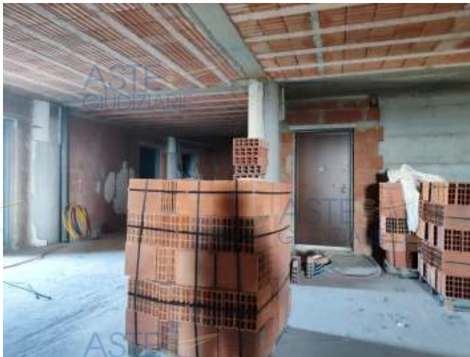
In primo piano, i pancali con sopra i blocchi i laterizio da cm 8 per le tramezzature non realizzate.
