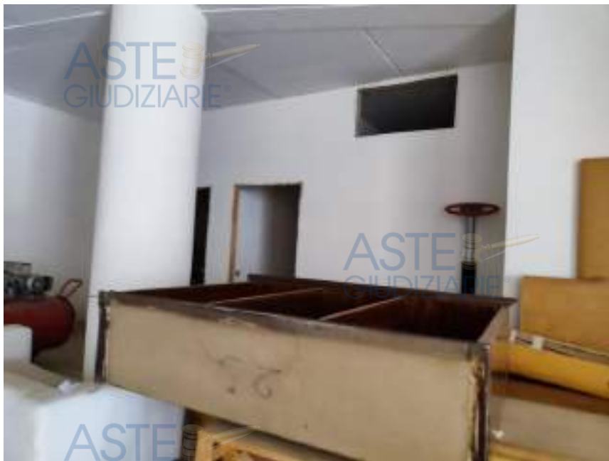
VISTA VERSO LE DUE PORTE CHE PORTANO ALLE ZONE DI SERVIZIO.
