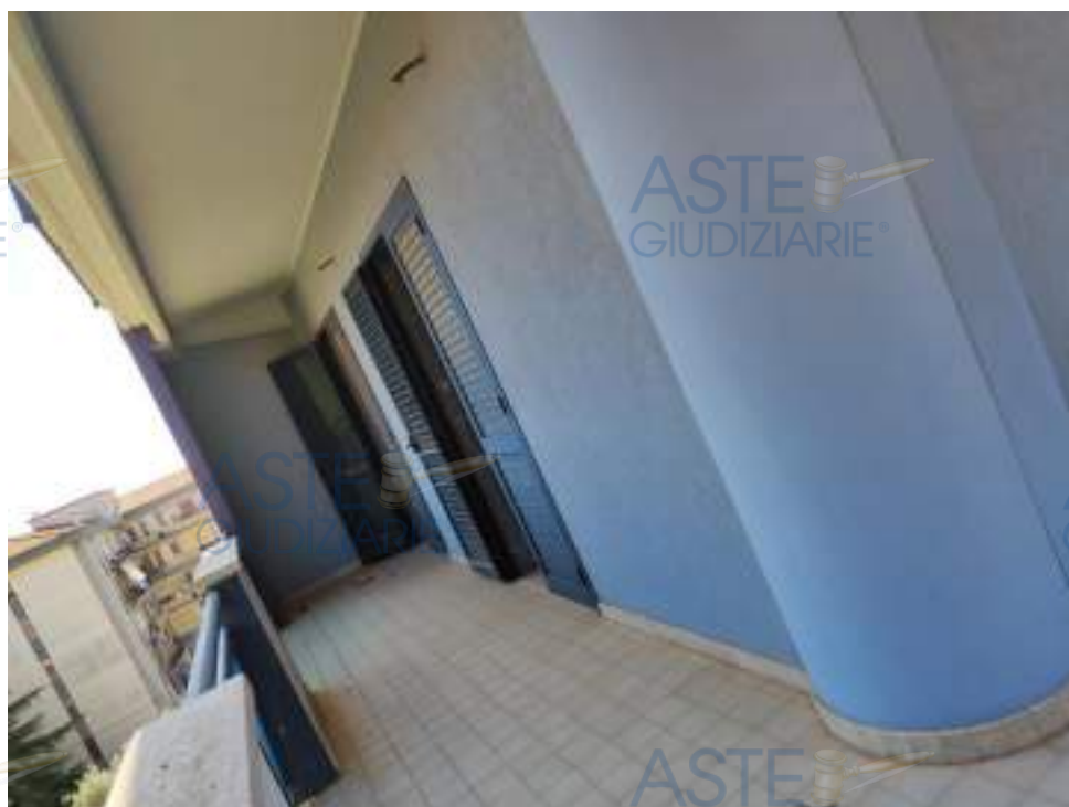
Balcone con porta finestre sulla Via A. Guastafarro.
