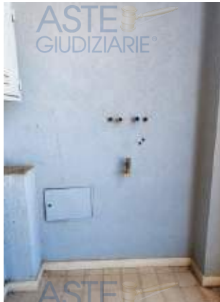
CASSETTA PER IL CONTENIMENTO DEL CONTATORE DEL GAS E DELL'ACQUA. PREDISPOSIZIONE DELLA CALDAIA.
