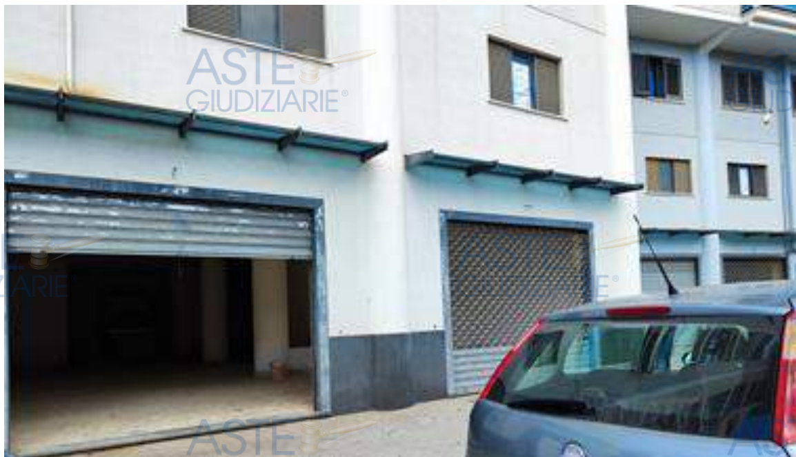
DALLA VIA A. GUASTAFERRO - SEMINTERRATO 2, DUE AMPI INGRESSI.
