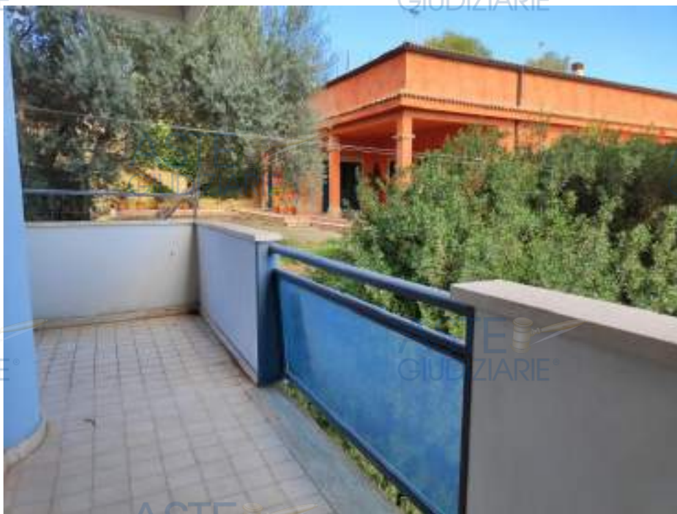
Il balcone perimetra per due lati il fabbricato sul lato Nord Est e sul lato Nord Ovest.
