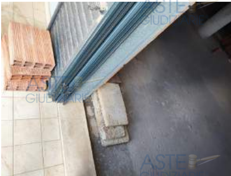
Particolare della pavimentazione tra esterno balcone finito ed interno da completare.
