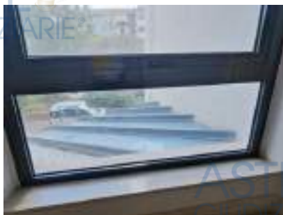
Veduta copertura dell'ingresso quota S2.
