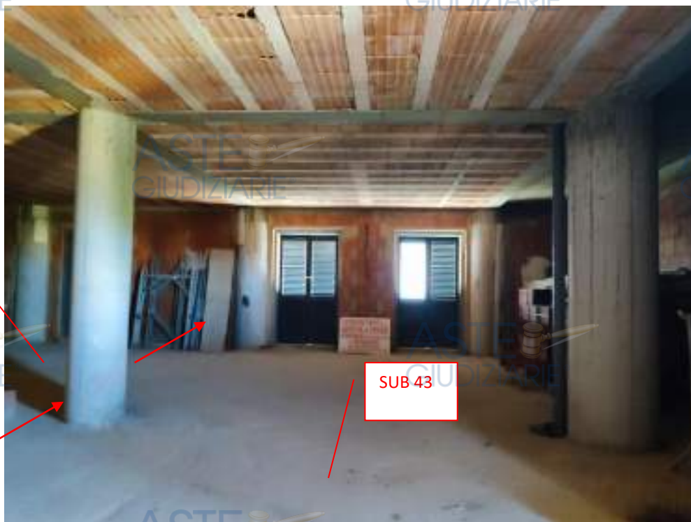
In prossimità dei pilastri a base circolare, sulla sx, la delimitazione del sub 43 con il sub 42.
