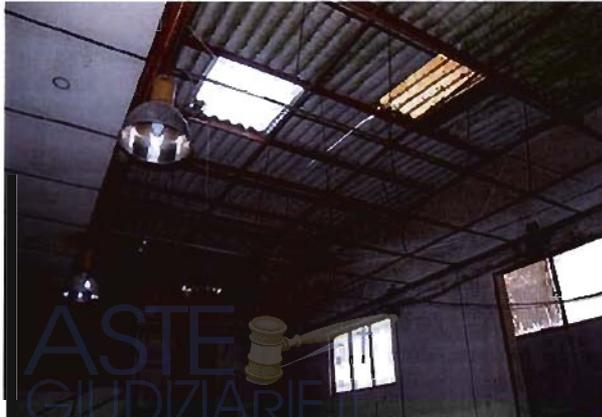
La struttura portante risulta essere in tubolari di ferro che, apparentemente, non risponde al benché minimo criterio costruttivo, per cui eseguito senza alcun calcolo statico e sicuramente non idoneo per le norme sismiche. Anche per queste ragioni, dunque, l'opera deve essere demolita.
