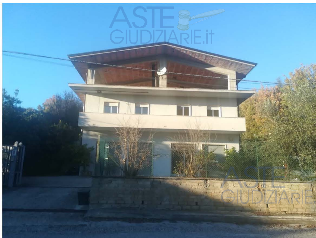
LATO SUD ACCESSO SU VIA FIUME
