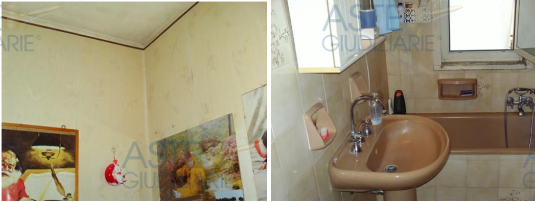
Il rivestimento delle pareti dei vani e del servizio igienico
