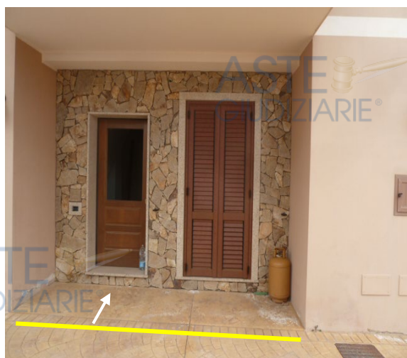
Foto n. 24 accesso e veranda
