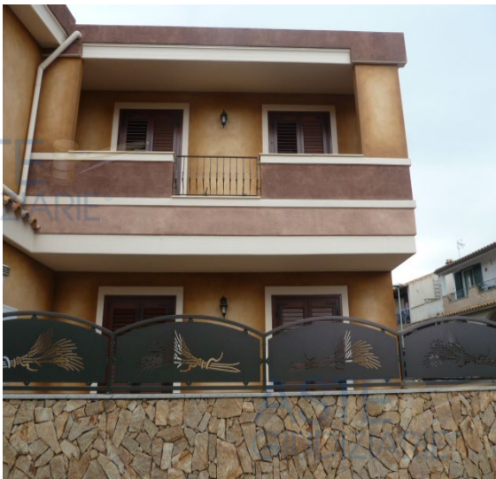
Foto n. 21 prospetto interno lato strada
