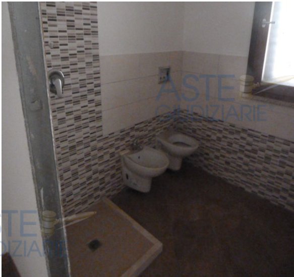
Foto n. 14 bagno piano T
