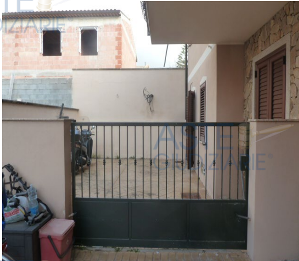
Foto n. 38 accesso cortile principale
