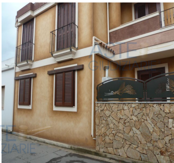
Foto n. 6 prospetto interno lato strada
