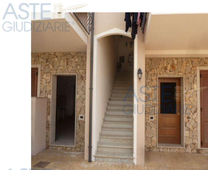
Foto n. 40 scale di accesso
