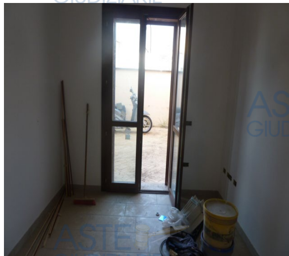
Foto n. 35 vano letto singolo
