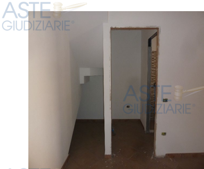
Foto n. 24 antebagno e ripostiglio piano T
