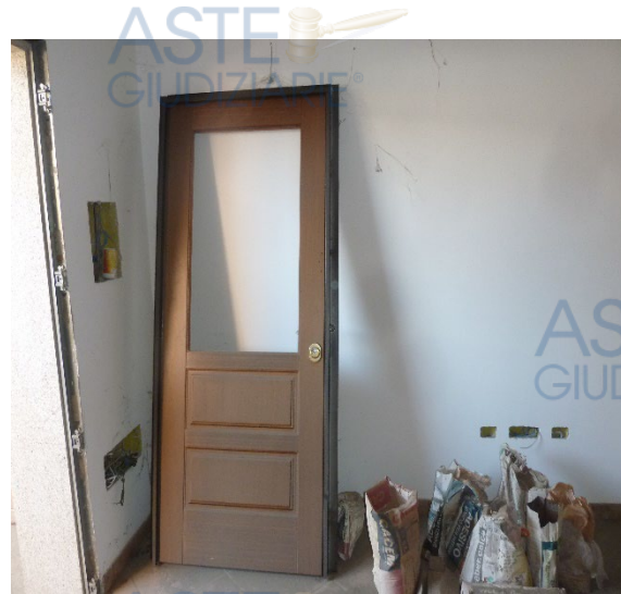
Foto n. 25 portoncino ingresso da montare
