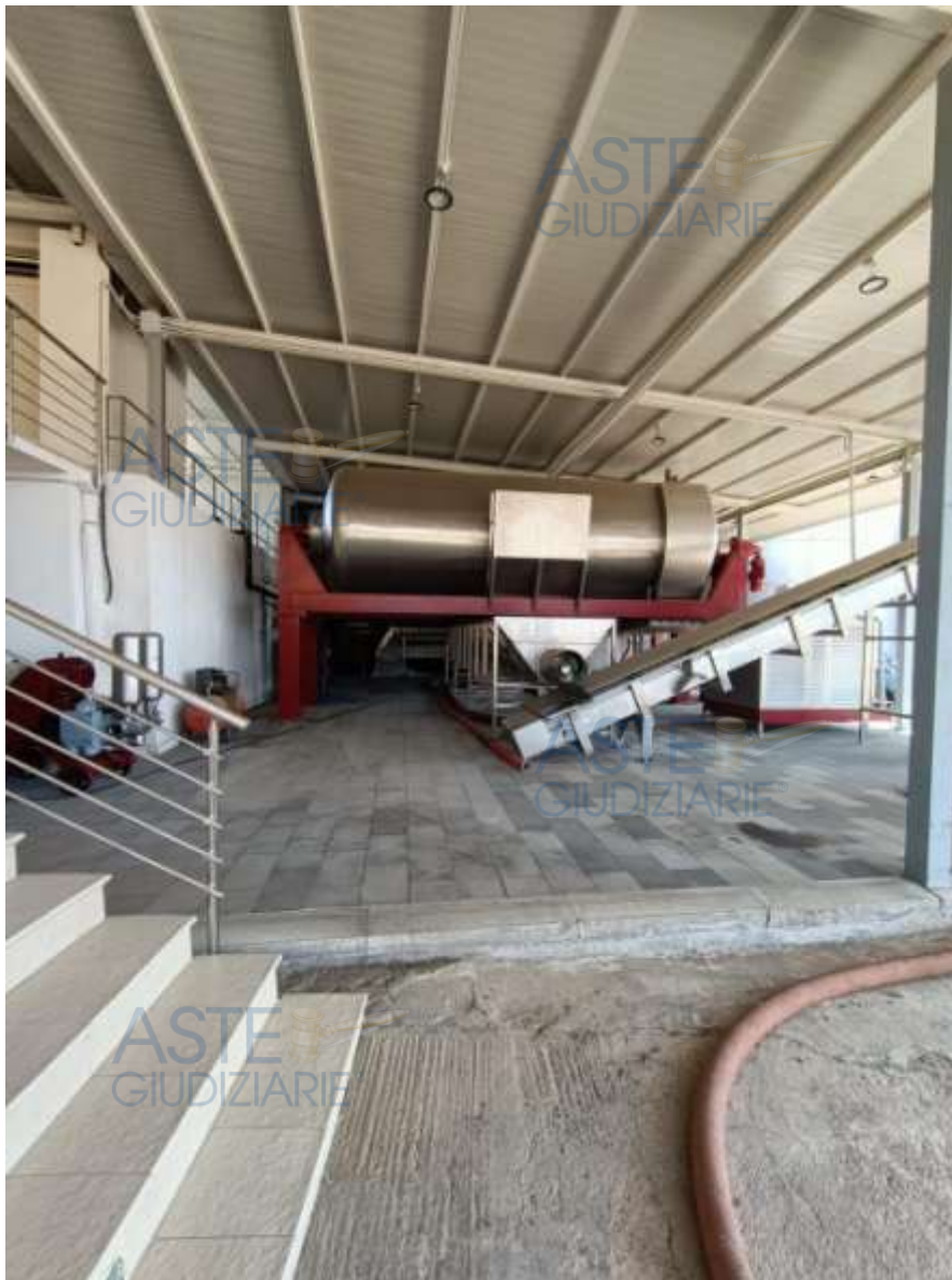
Vista dello spiazzale con pavimento macchinario e tettoia
