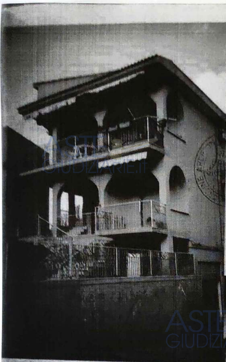
FOTO 1 PROSPETTO SULLA VIA S. D'ANNUNZIO
