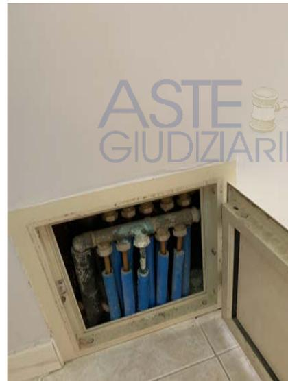
Figura 12 – Collettore impianto di riscaldamento
