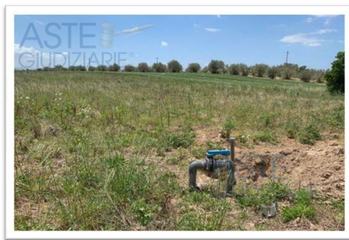
Fig. 13 – Lotto 2: saracinesce idrauliche
