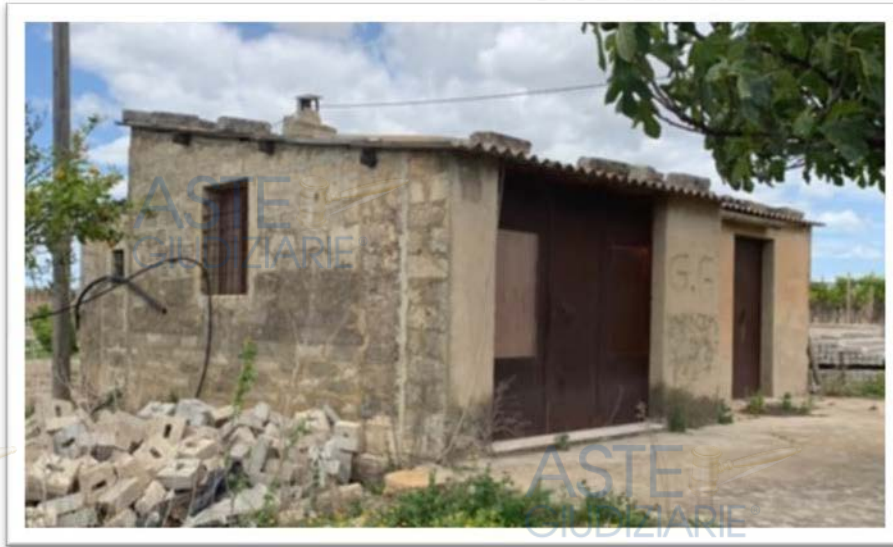
Fig. 7a – Lotto 1: fabbricato rurale edificato sulla part. 281 del foglio n°13
