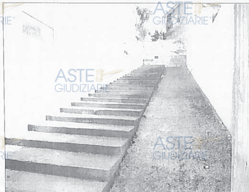
FOTO N. 28 - GARAGE SUB 16 - SCIVOLA
