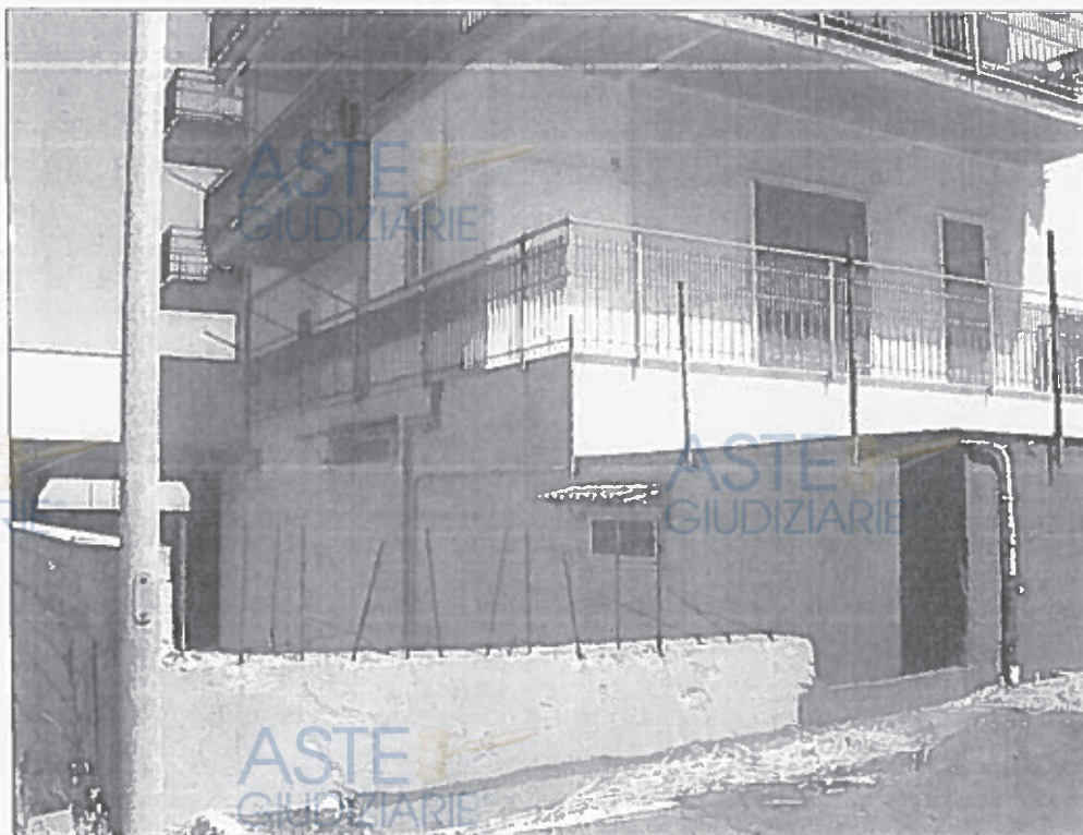
FOTO N. 27 - GARAGE SUB 16 - INGRESSO SCIVOLA
