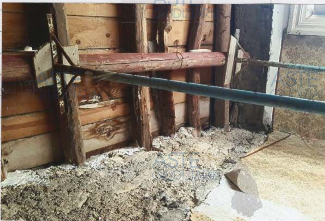
Posa in opera dei sostegni
