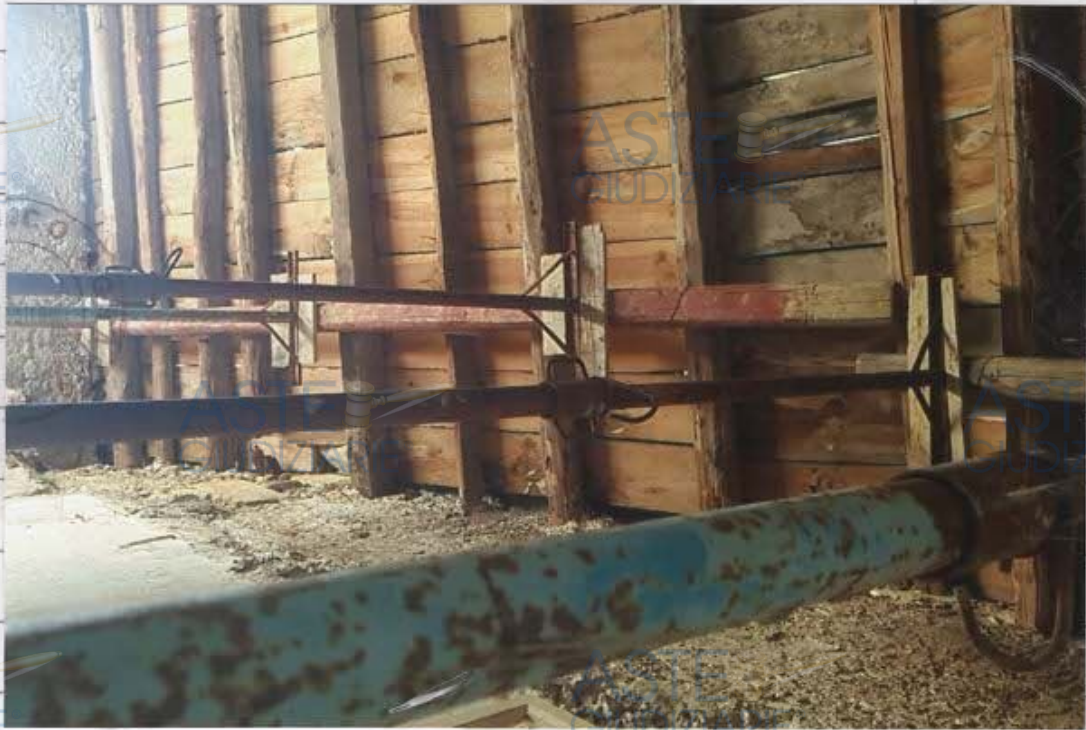
Posa in opera delle travi in legno e relativi sostegni
