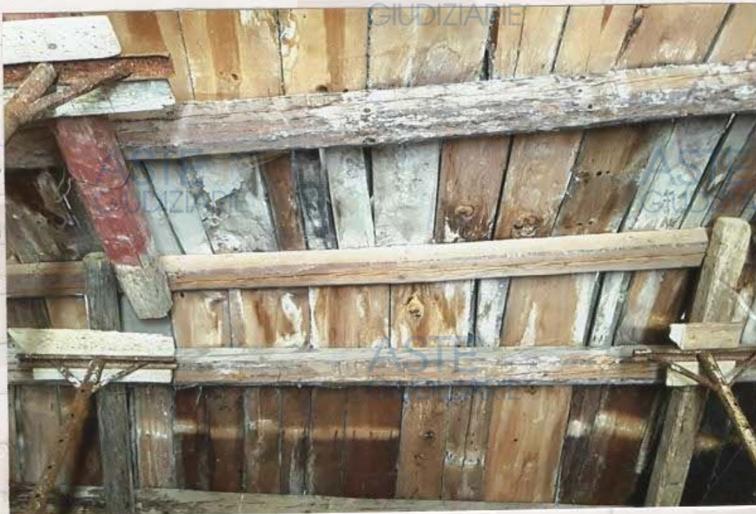
travi in legno sostituite
