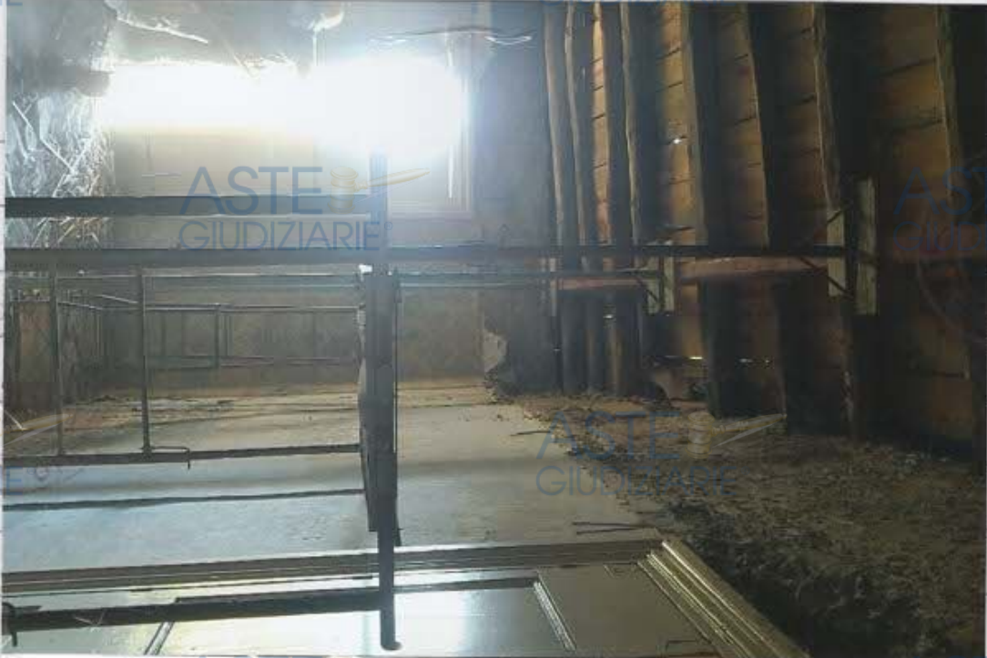
Formazione della interfaccia con sostegni in ferro.
