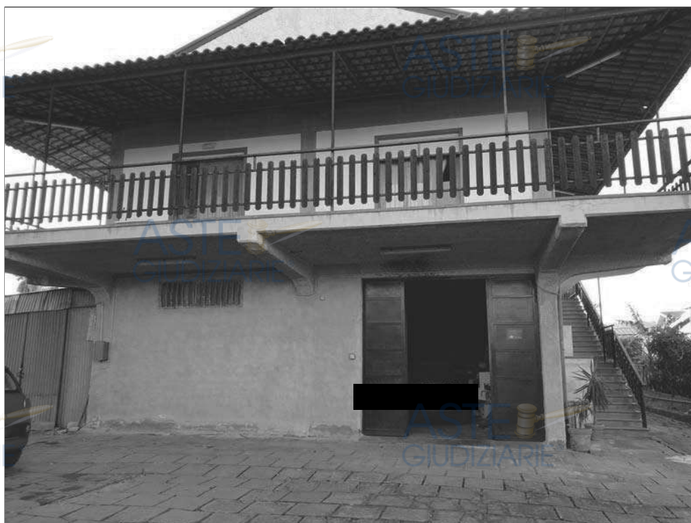
FOTO 02: PROSPETTO PRINCIPALE DEL FABBRICATO
