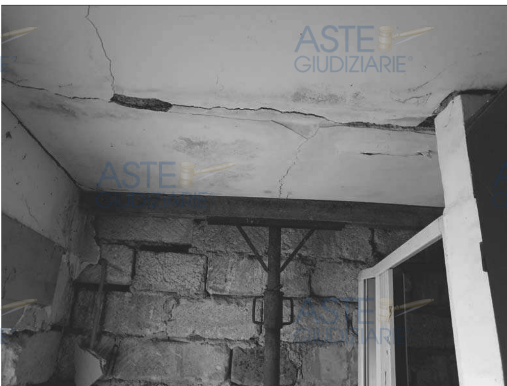
FOTO 14: SERVIZIO IGIENICO - LESIONI SU MURI E SU SOLETTA DI COPERTURA. PUNTELLO A SOSTEGNO DELLA SOLETTA.
