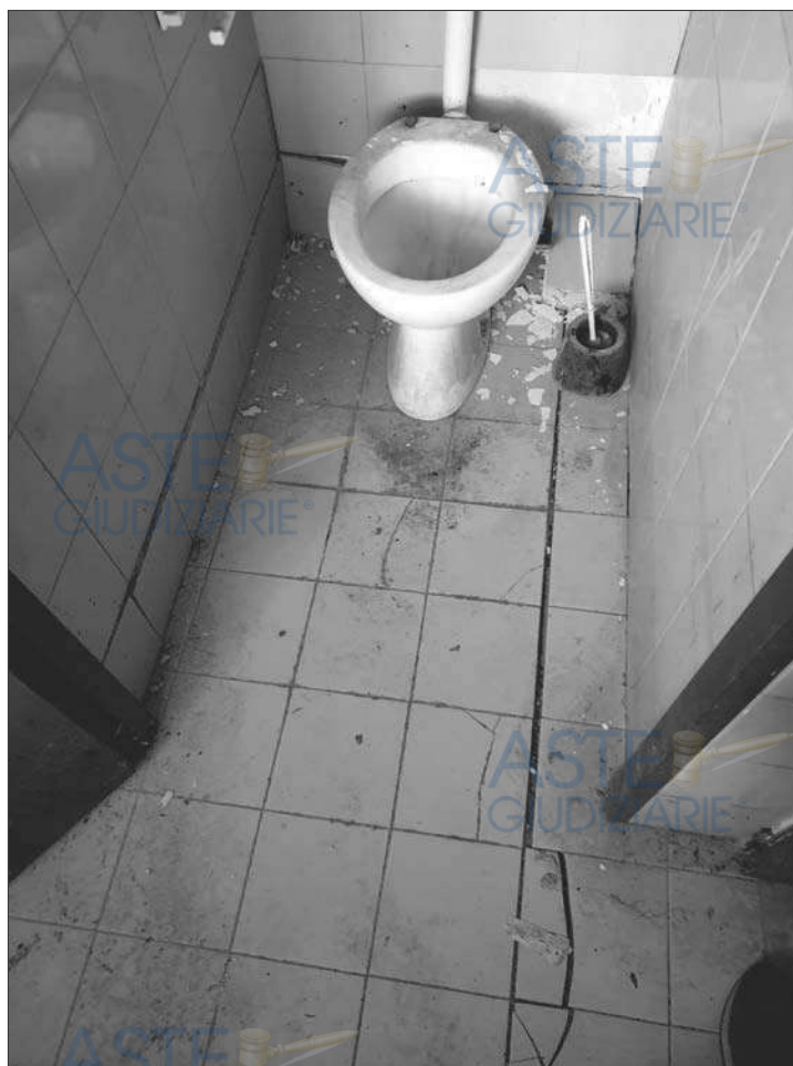
FOTO 18: W.C. - LESIONI A PAVIMENTO SUL GIONTO TRA LE FONDAZIONI
