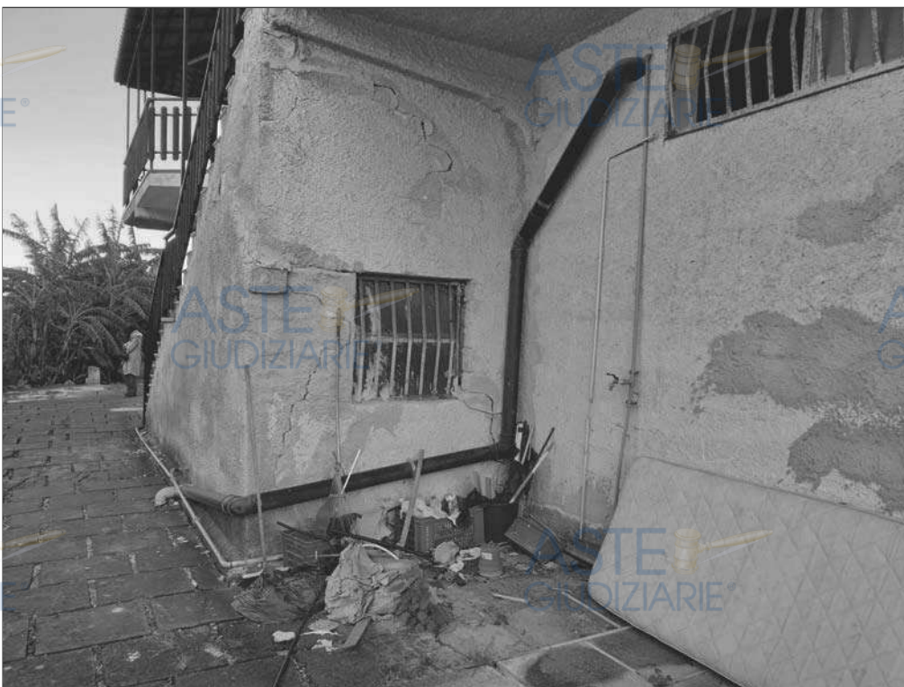
FOTO 20: VISTA ESTERNA DEL MURO DI TOMPAGNO DEL W.C.
