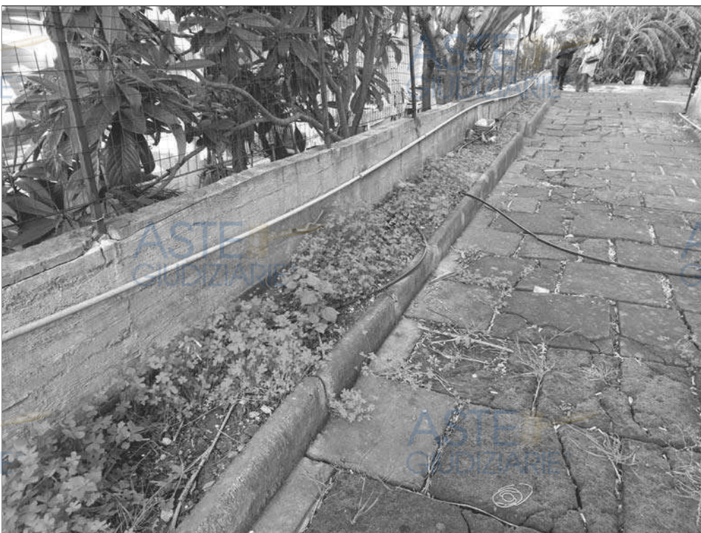
FOTO 24: MURETTO DI CONTENIMENTO SPINTO E RUOTATO VERSO L'ESTERNO
