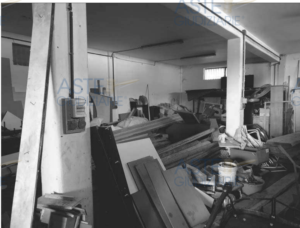
FOTO 03: INTERNO DEL MAGAZZINO
