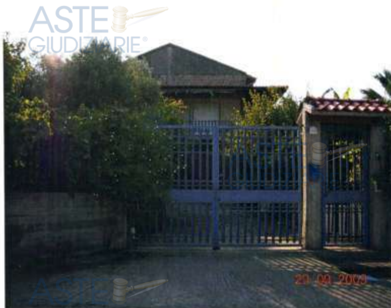
FOTO 1 - Vista dell'immobile dalla Via Bachelet
