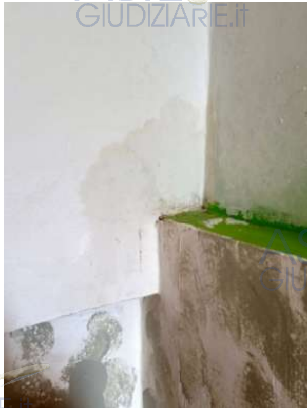
Muro adiacente la scala che porta al secondo livello
