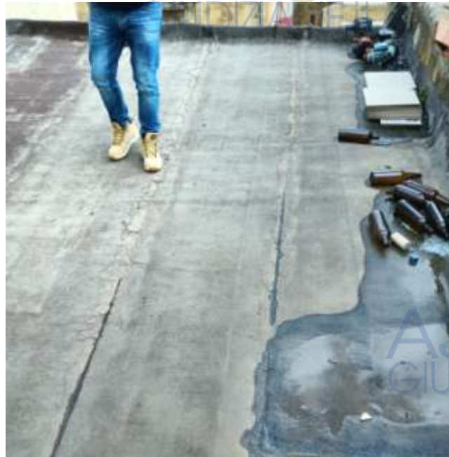
Guaina ammalorata in corrispondenza delle giunture e cristallizzata
