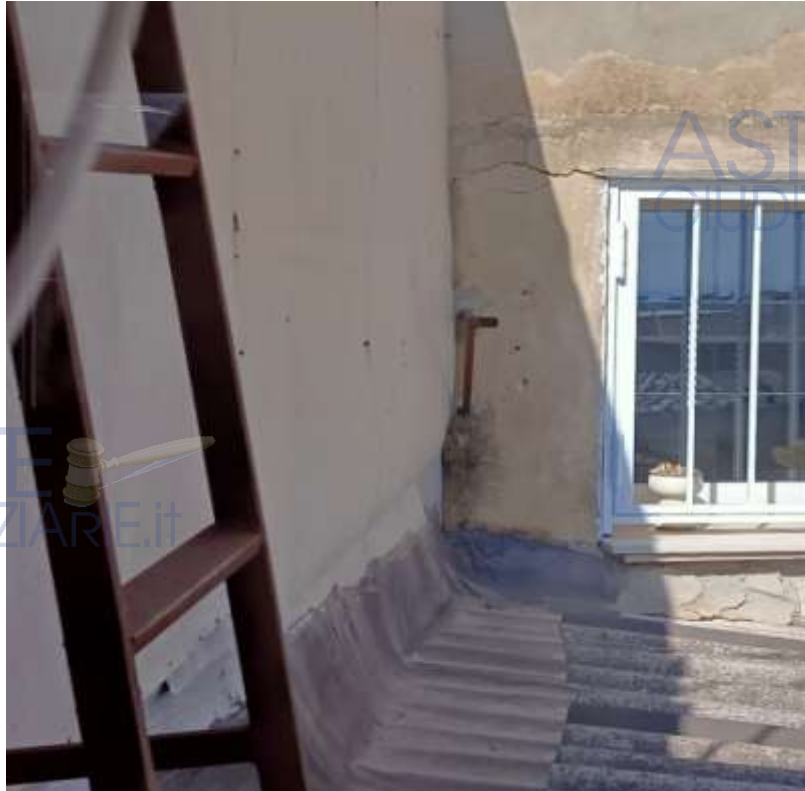
Copertura metallica in corrispondenza della rampa di scale
