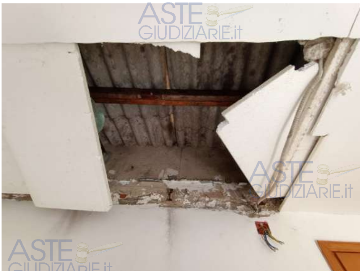
Copertura in ETERNIT
