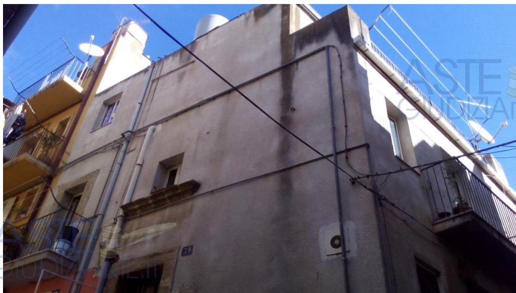
Prospetto di Via Marcinnò
