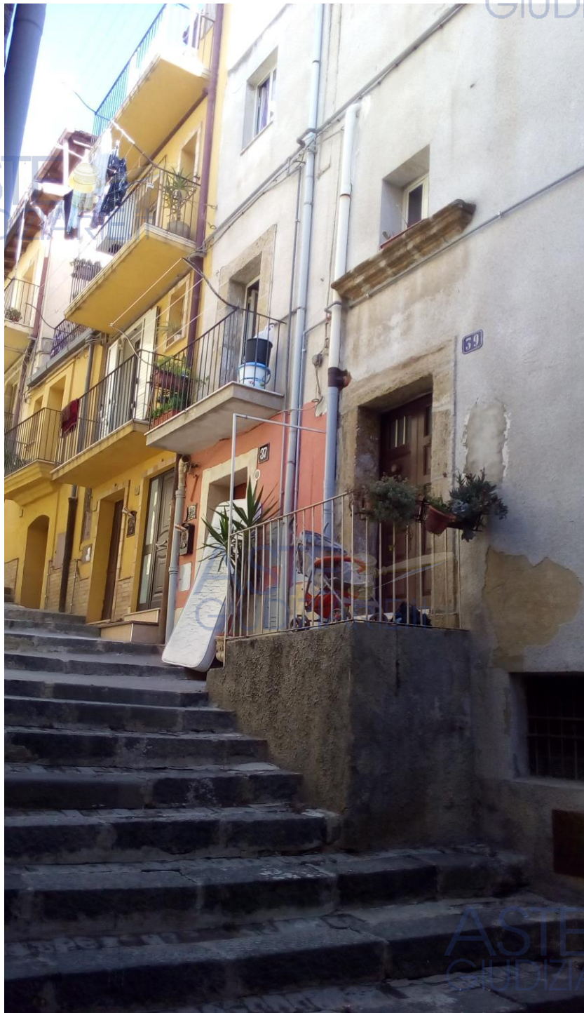
Prospetto di Via Marcinnò
