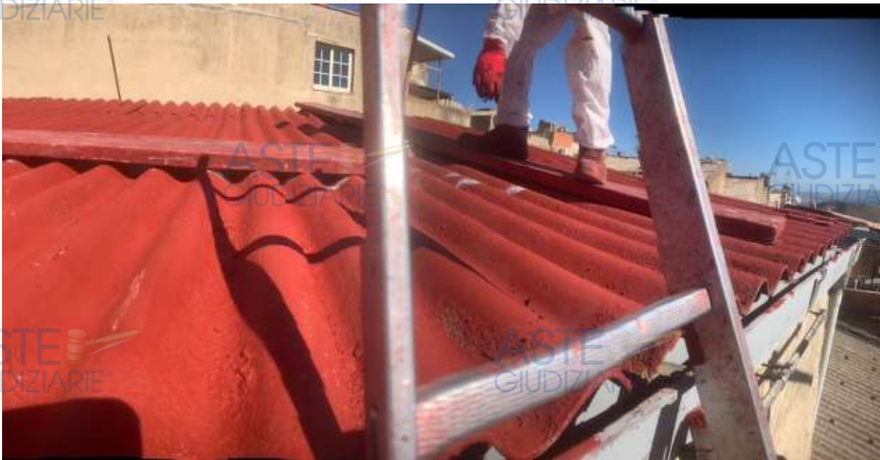
Tetto trattato con resina epossidica
