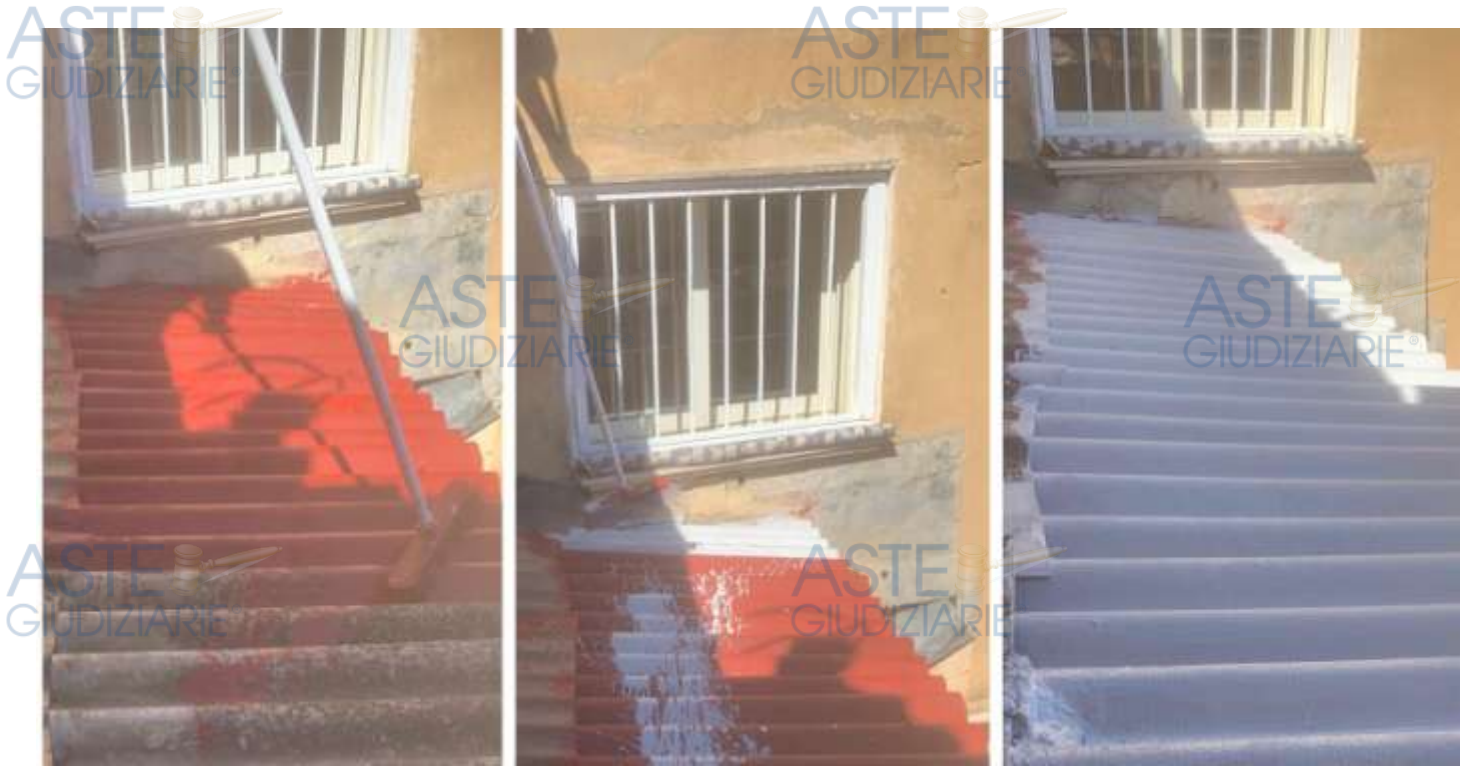
Interventi realizzati sul tetto del ripostiglio
