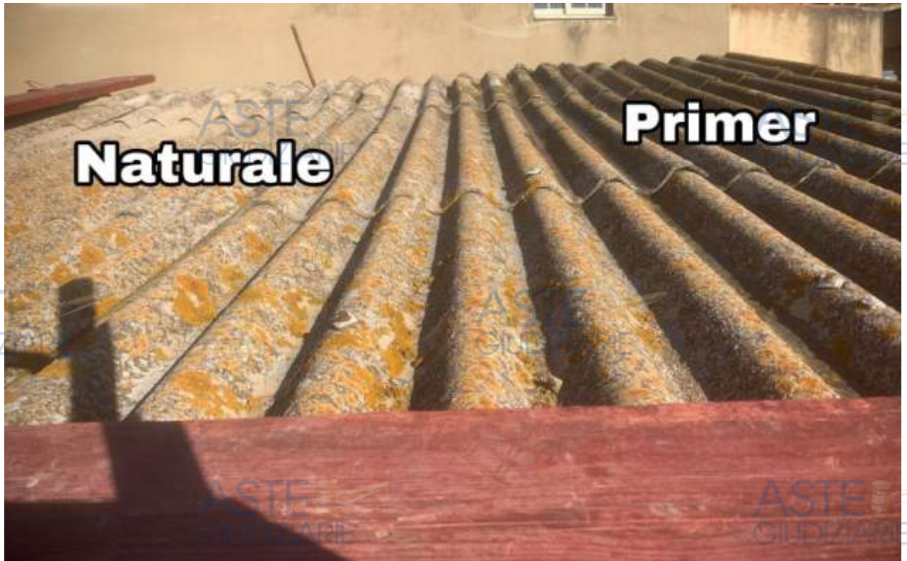
Porzione di tetto trattato con primer
