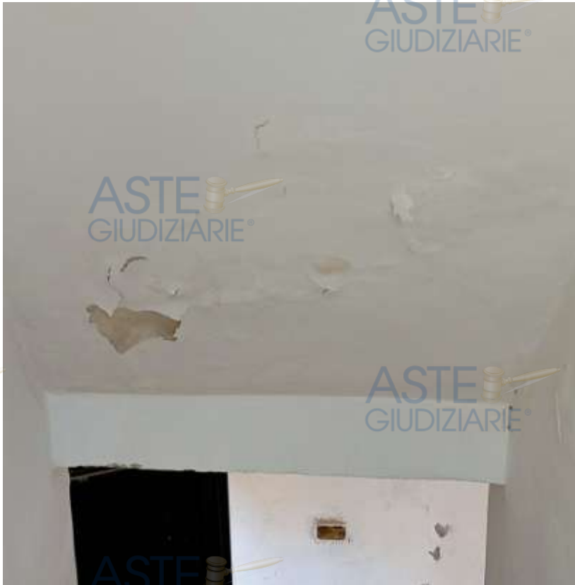
Infiltrazione nel vano scala in corrispondenza del doppio servizio del primo livello
