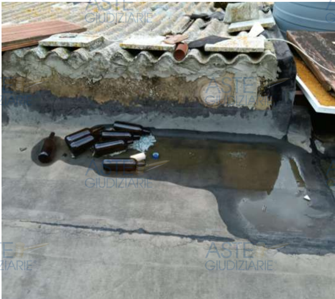
Fessura della guaina con tracce di acqua
