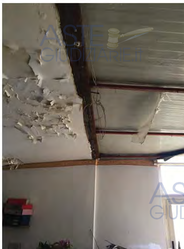
Foto 12 – Unità immobiliare identificata al Catasto al fg 141, part. 501, sub 3 - Piano Secondo – Punto di delimitazione tra copertura stanza e copertura terrazzo
