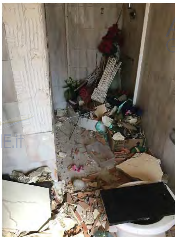
Foto 7 – Unità immobiliare identificata al Catasto al fg 141, part. 501, sub 2 - Piano Primo - Bagno
