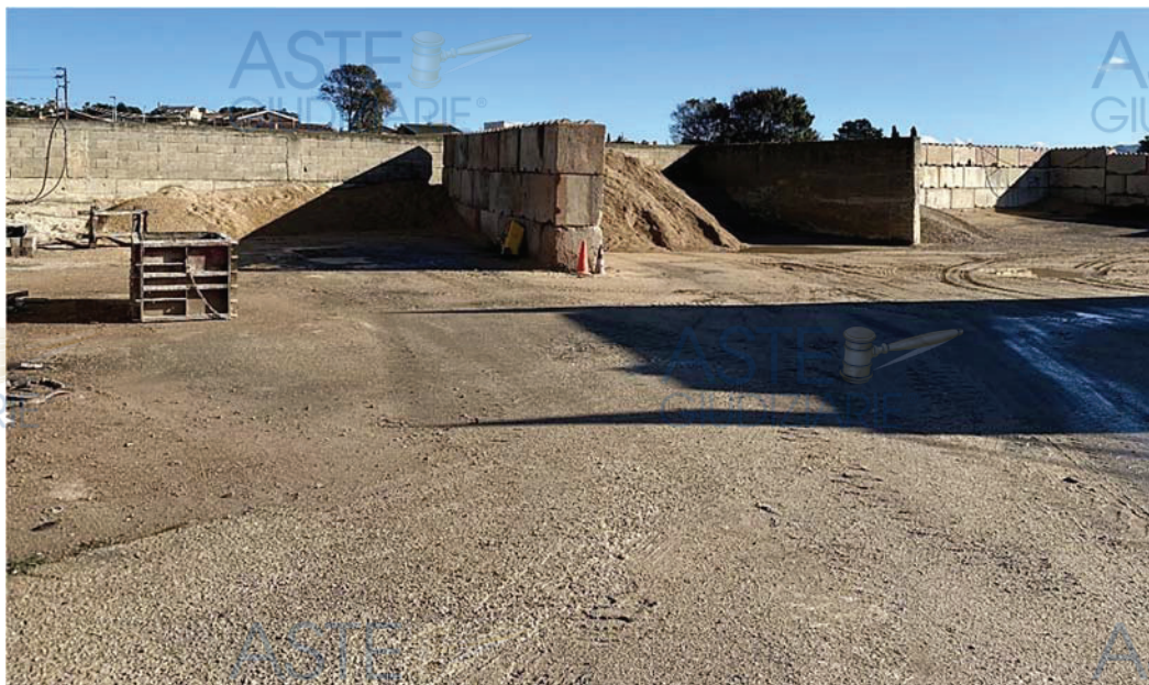
Tipologia della recinzione cieca realizzata con blocchetti di calcestruzzo su muro di sostegno
