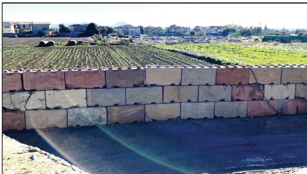
Tipologia della recinzione cieca realizzata con blocchi sovrapposti
