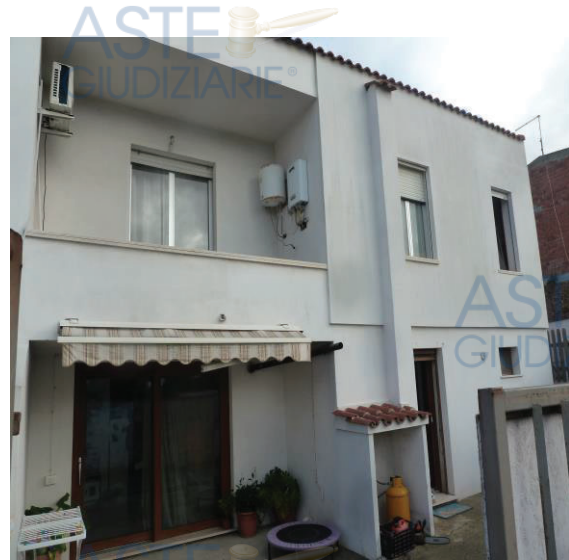
Foto n. 5 prospetto su via Camposanto
