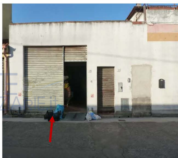
Foto n. 3 ingresso magazzino civico 2b
