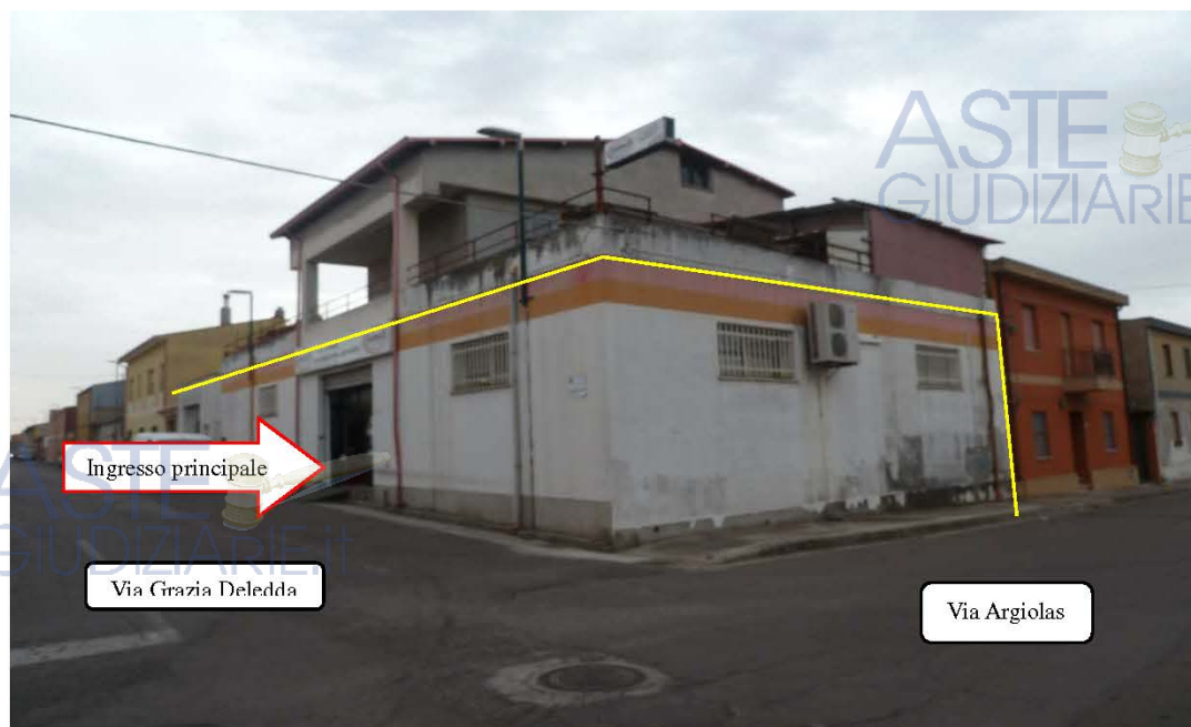
Foto n. 1 prospetti del locale
