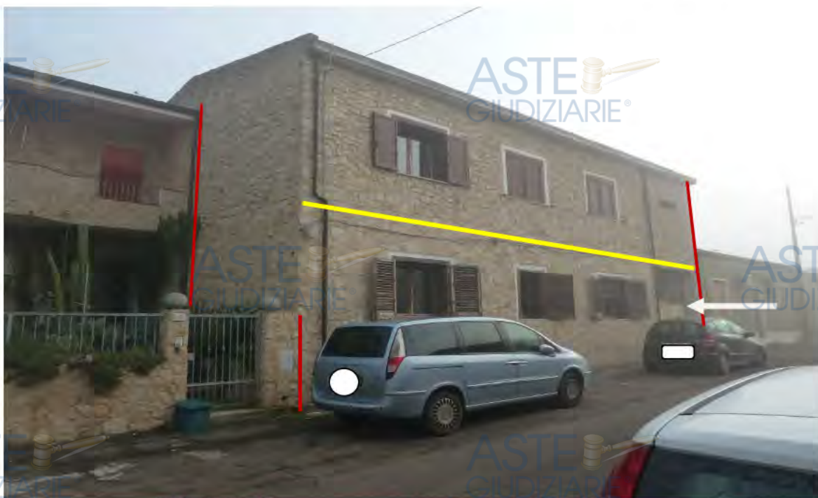
Foto n. 1 prospetto principale sulla via Satta
