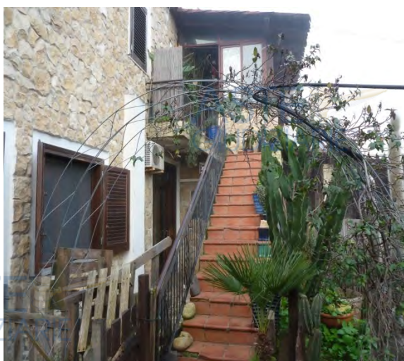
Foto n 1 scala di accesso
