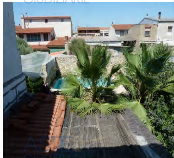
Foto n. 25 coperture e vista piscina
