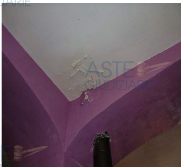
Foto n. 23 infiltrazione
