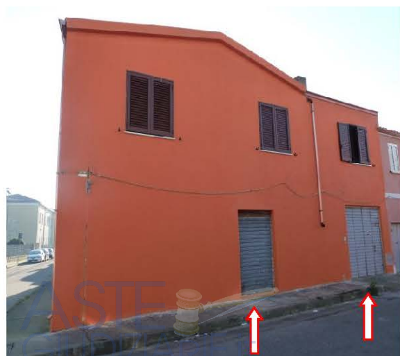
Foto n 1 fabbricato e accessi
