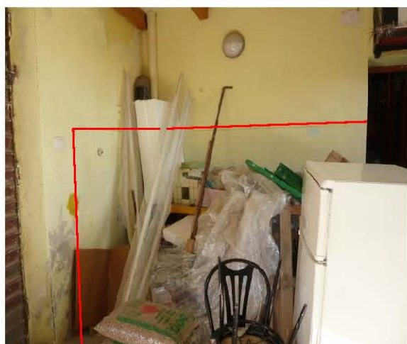
Foto n. 5 area ex bagno
