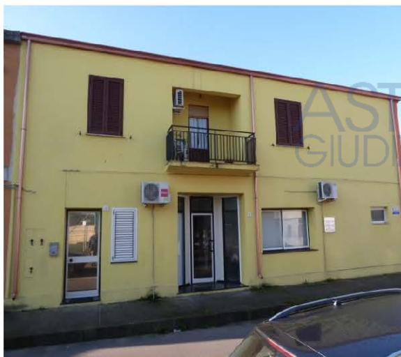
Foto n. 2 prospetto via Dante
