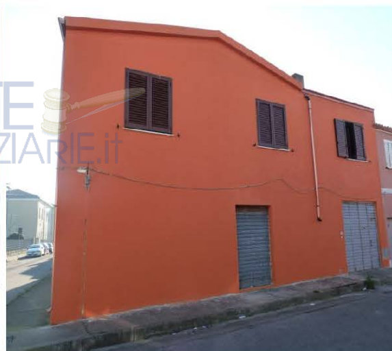
Foto n. 3 prospetto via Is Argiolas
