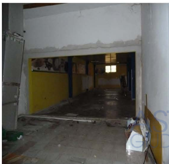
Foto n. 7 varco lato magazzino
