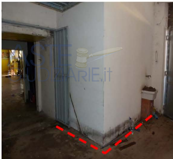
Foto n. 1 area in possesso sub 2
