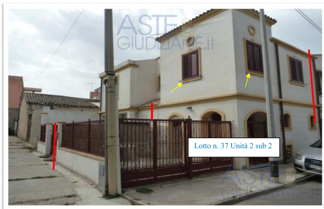
Foto n. 2 Lotto n. 37 le frecce gialle indicano difformità di prospetto
