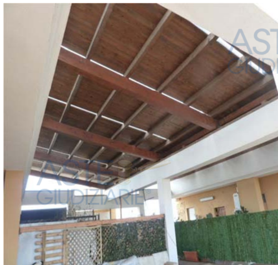
Foto n. 7 Particolare copertura terrazza
