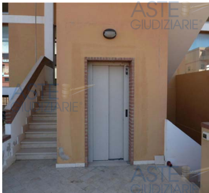
Foto n. 8 Vano scala e cabina ascensore
