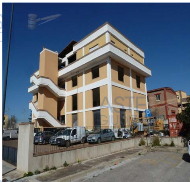
Foto n. 11 Muretto via Fleming
