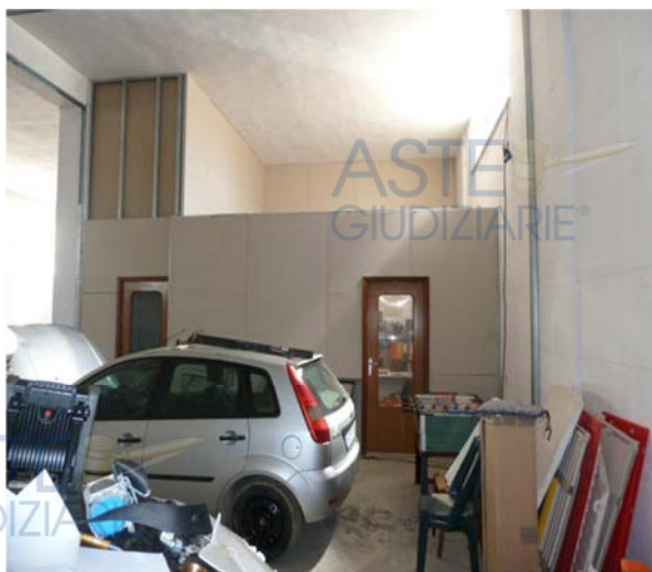
Foto n. 23 Divisioni interne piano seminterrato
