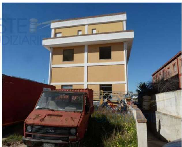
Foto n. 4 Prospetto su area libera e scivolo
