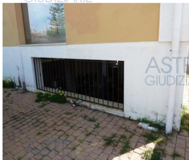
Foto n. 28 Apertura vista dall'esterno
