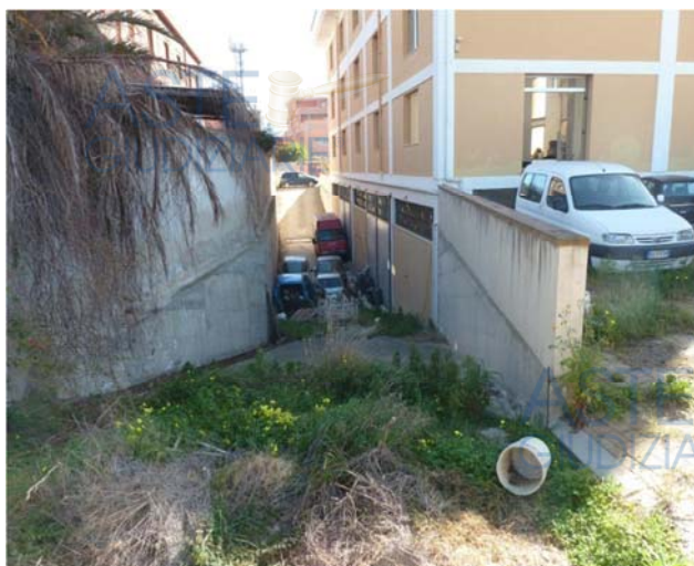
Foto n. 5 Prospetto interno e scivolo via Galvani
