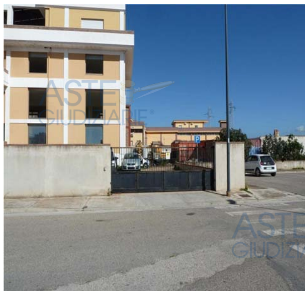
Foto n. 10 Muro e ingresso carraio via Fleming
