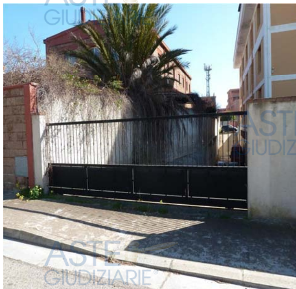
Foto n. 14 Muro e ingresso carraio via Galvani
