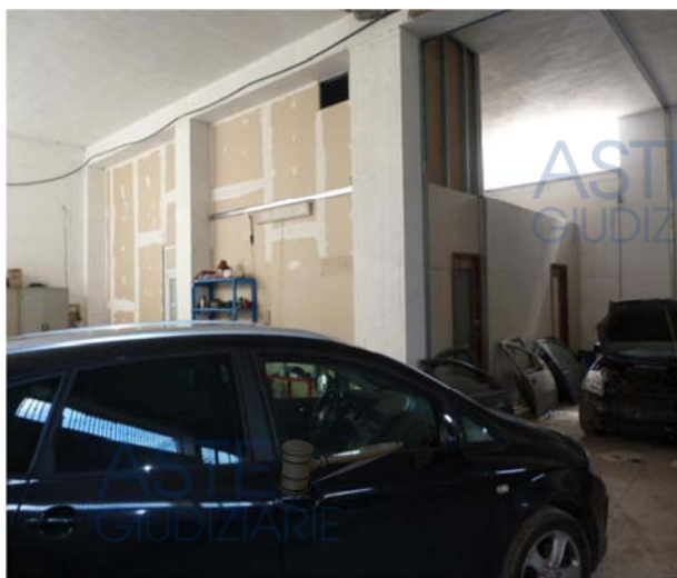
Foto n. 24 Divisioni interne piano seminterrato
