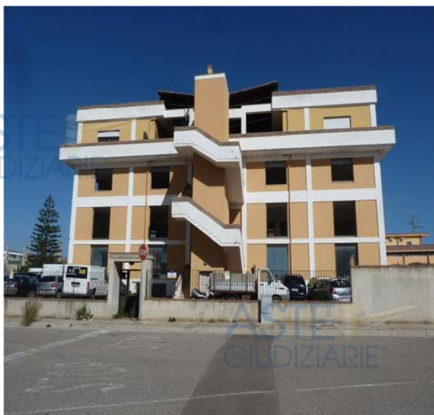
Foto n. 9 Muretto e ingresso pedonale via Fleming
