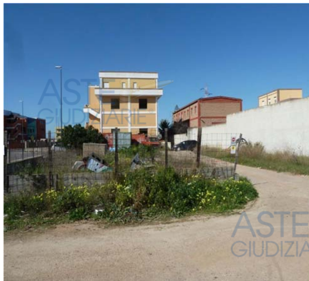
Foto n. 3 Prospetto laterale su area libera
