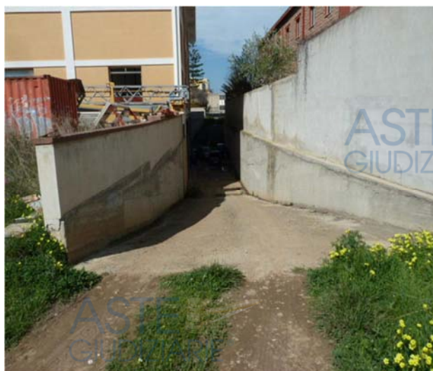
Foto n. 18 Scivolo via Fleming
