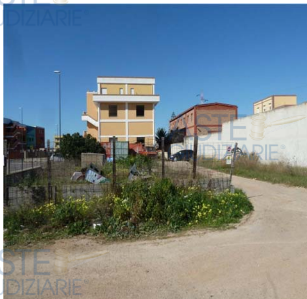
Foto n. 13 Lato da ultimare vicolo via Fleming
