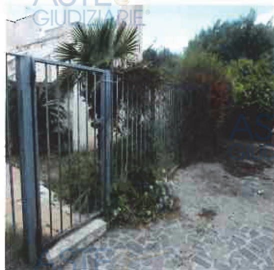
Foto n. 2 Cancelli pedonale interno
