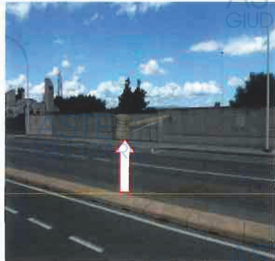
Foto n. 2 Prospetto stradale e accesso carrabile
