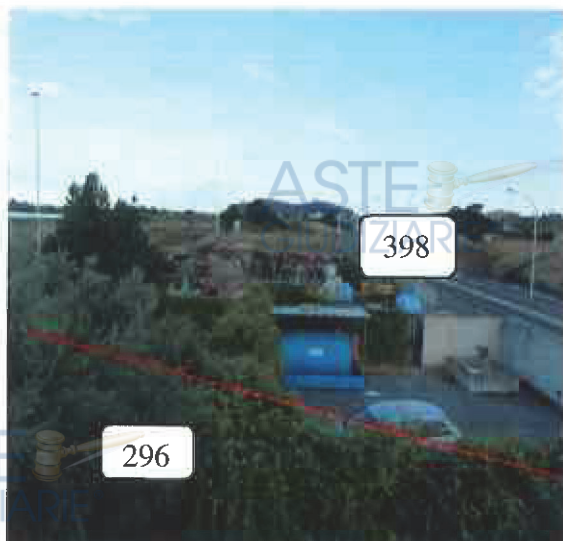
Foto n. 3 Parcheggio visto dalla terrazza
