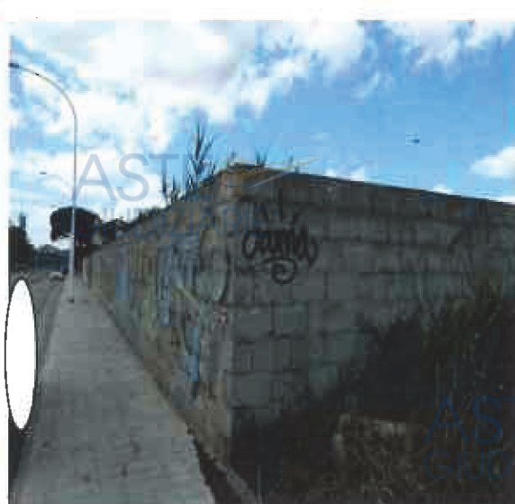
Foto n. 4 Prospetto via dei Conversi
