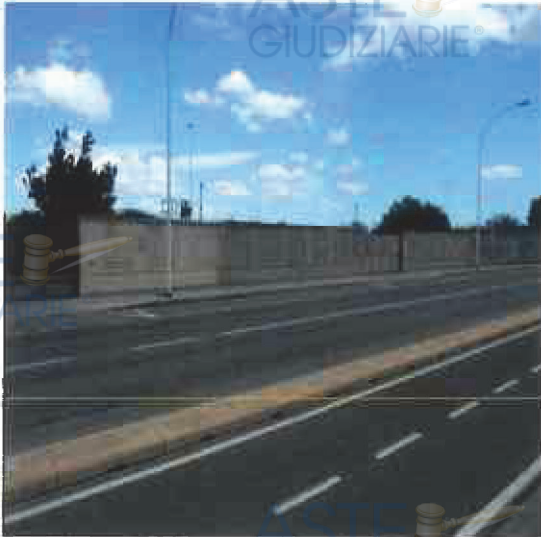
Foto n. 1 Prospetto via dei Conversi
