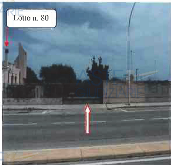
Foto n. 1 Prospetto stradale e accesso carrabile
