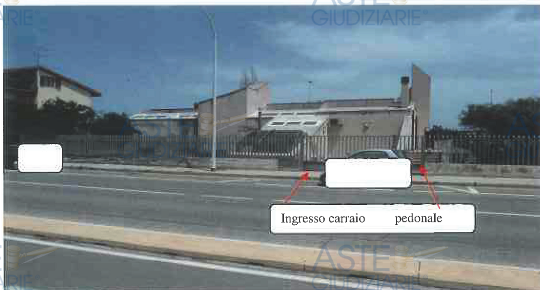
Foto n. 1 Prospetto sulla via dei Conversi
