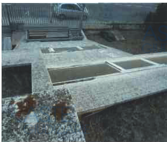
Foto n. 32 Particolare prospetto visto dalla terrazza
