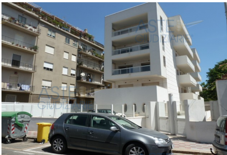
Fabbricato lato ingresso pedonale
