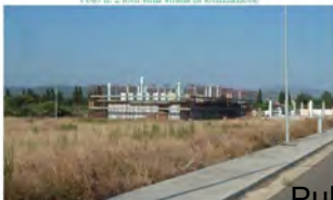
Foto n. 3 lotti da strada di lotizzazione e vista nuovo cantiere edilizio
