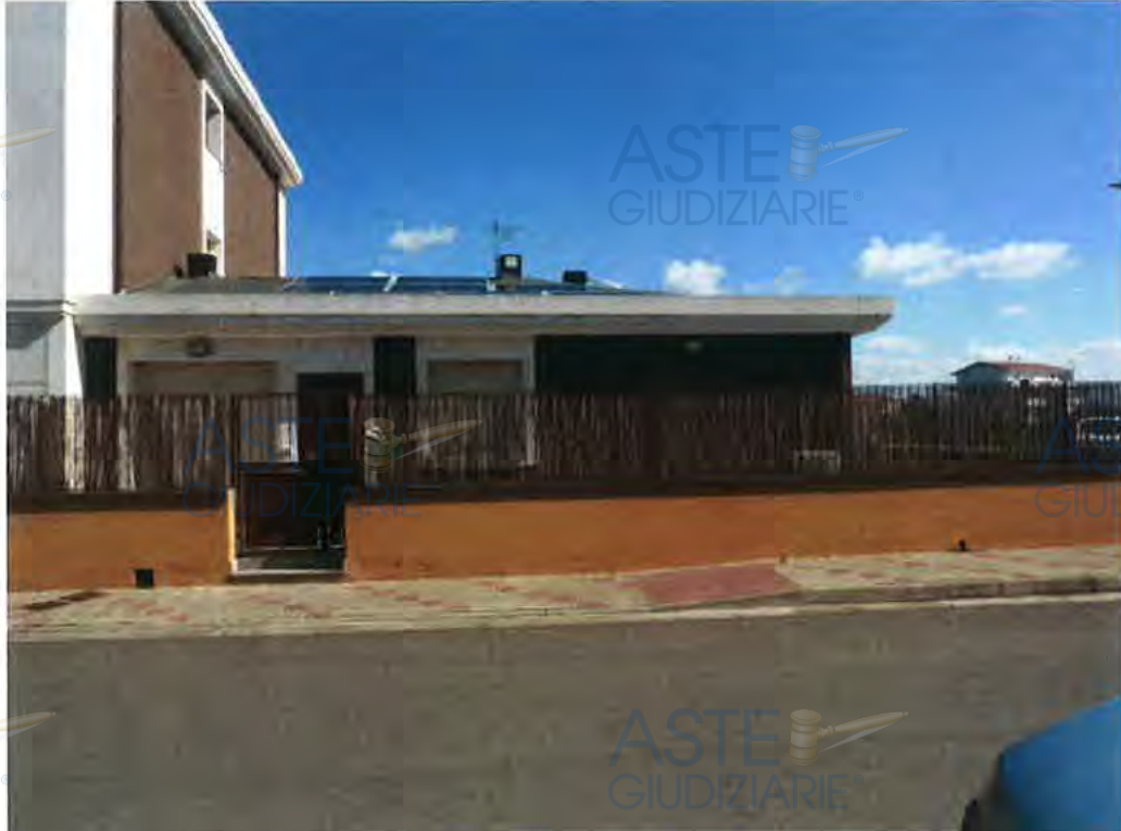
Foto n. 17 prospetto principale (riportata nell'allegato fotografico)
