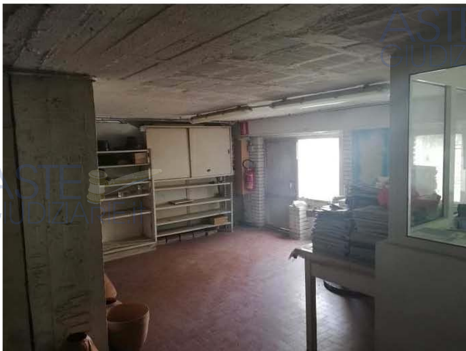
Ingresso via Abruzzi n° 15 e laboratorio piano terra
