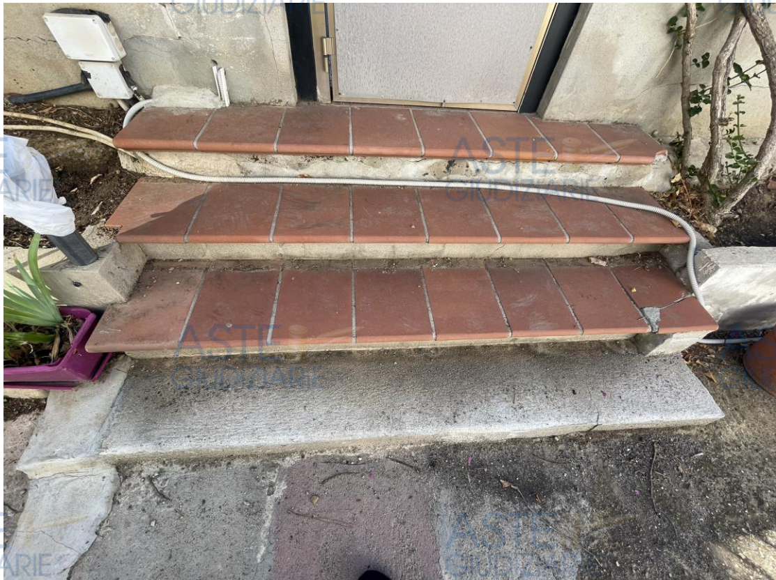
Gradini di ingresso dal cancello pedonale
