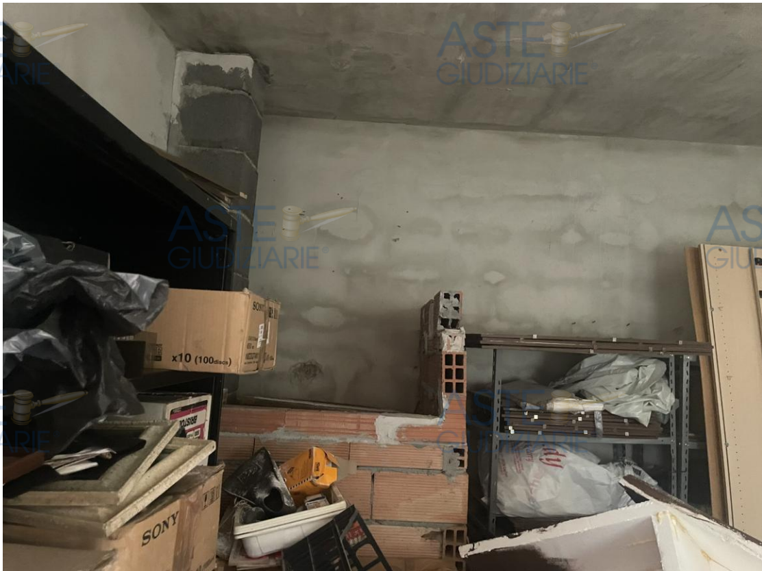
Vista interna del locale garage
