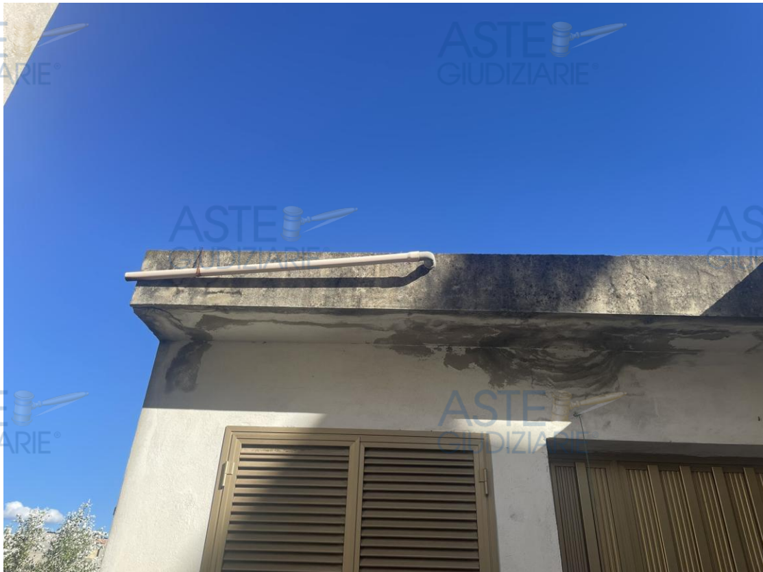
Copertura del locale accessorio
