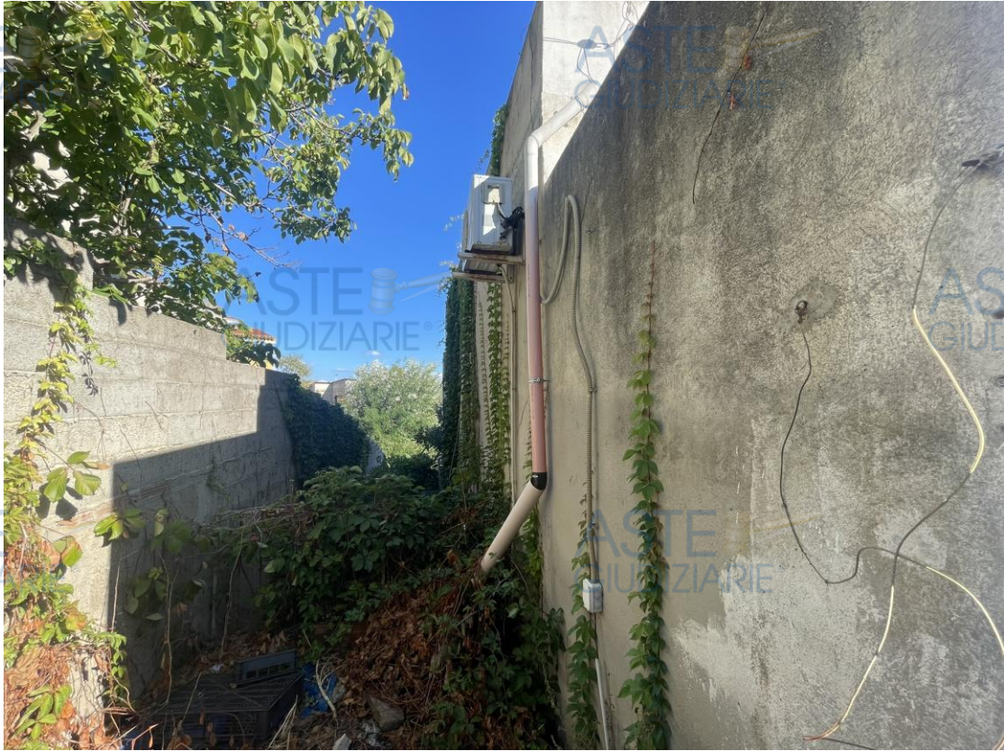
Vista del prospetto laterale destro
