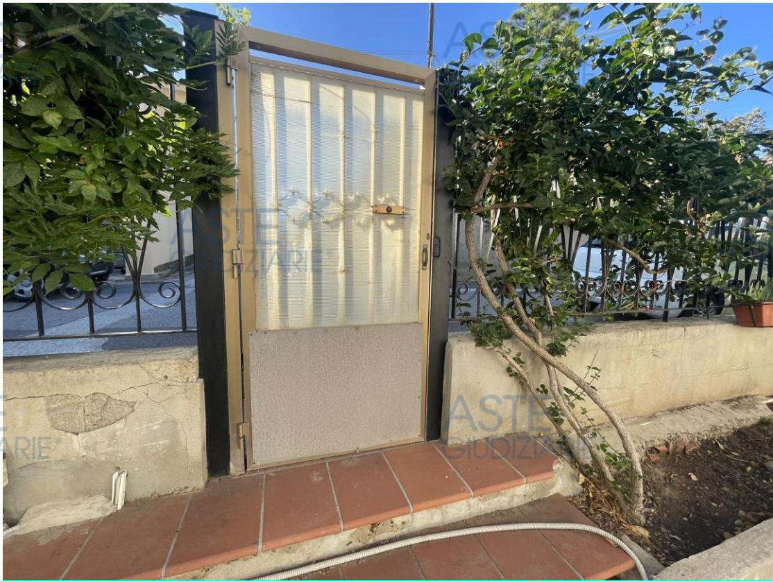
Vista del cancello di accesso pedonale
