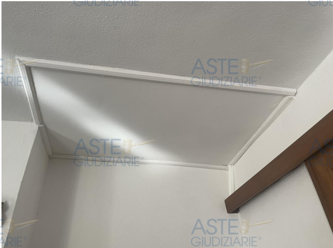
Predisposizione per il collegamento con la copertura
