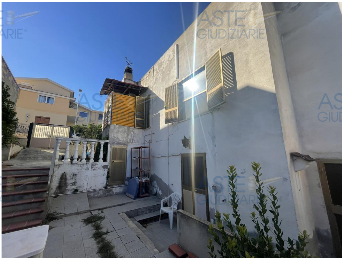
Vista del prospetto laterale destro
