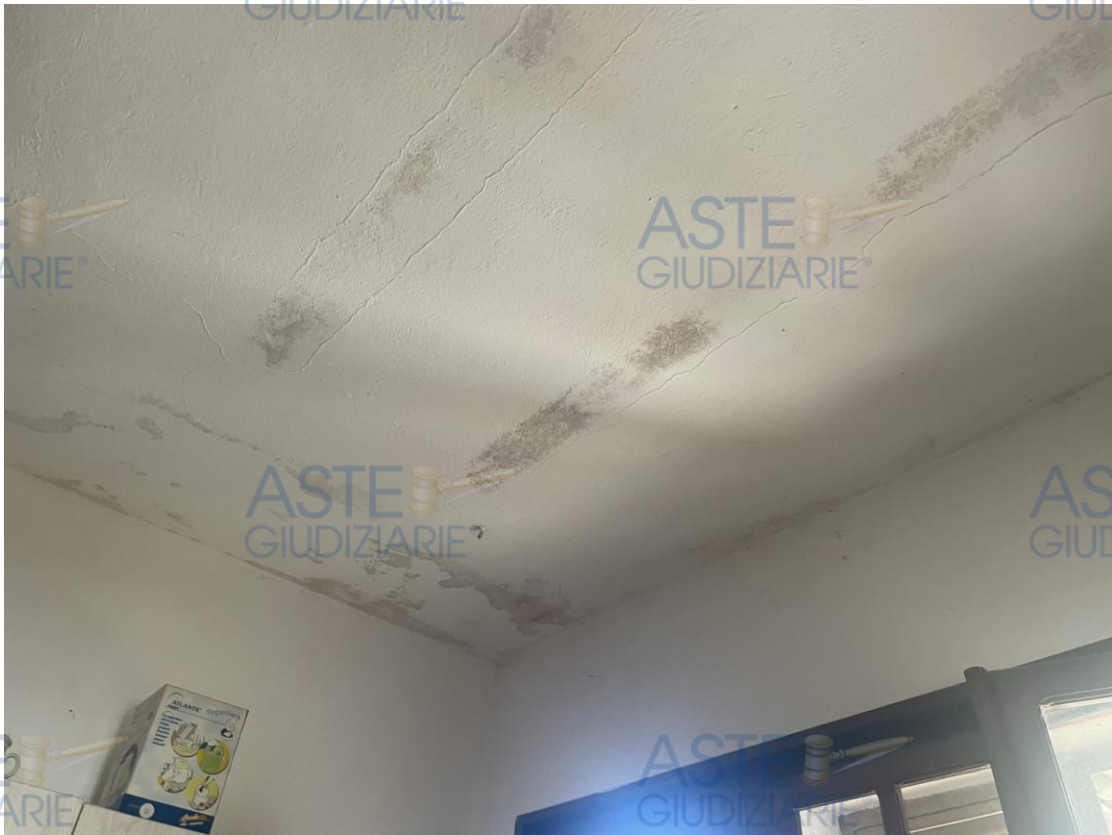
Particolare del soffitto della cucina
