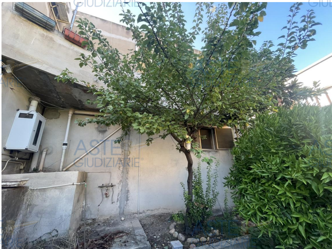
Vista del prospetto posteriore
