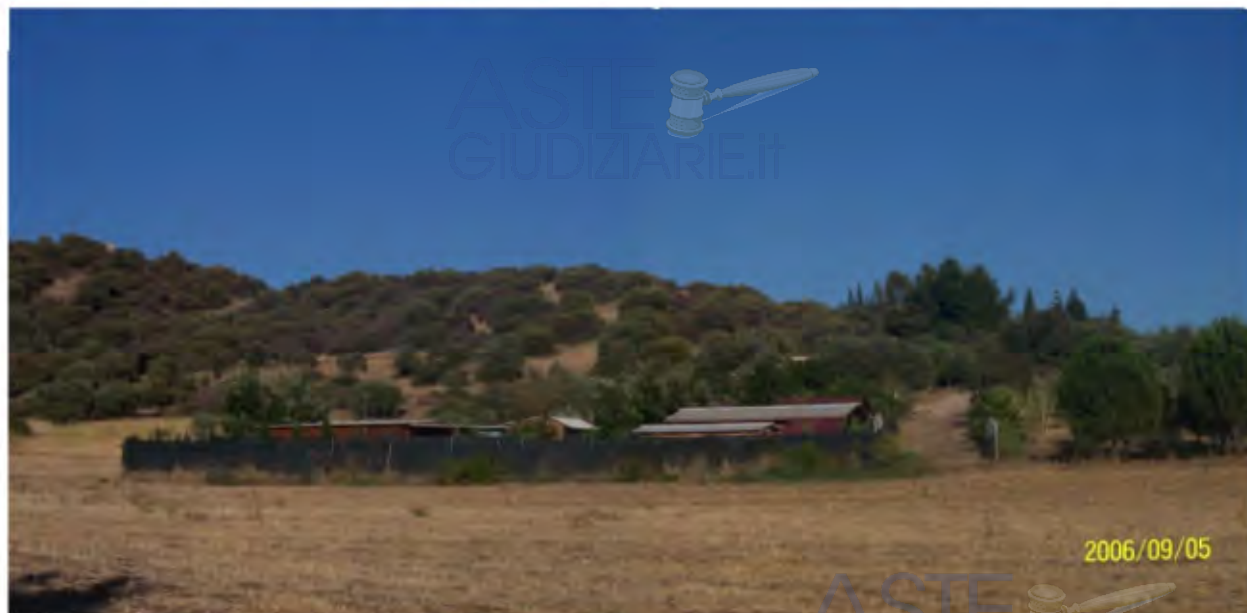
Foto 3.: dalla strada di accesso a Porto Columbu sono visibili gli immobili abusivi che sono sorti sul mappale 93 ed oggetto di ordinanza di demolizione.
