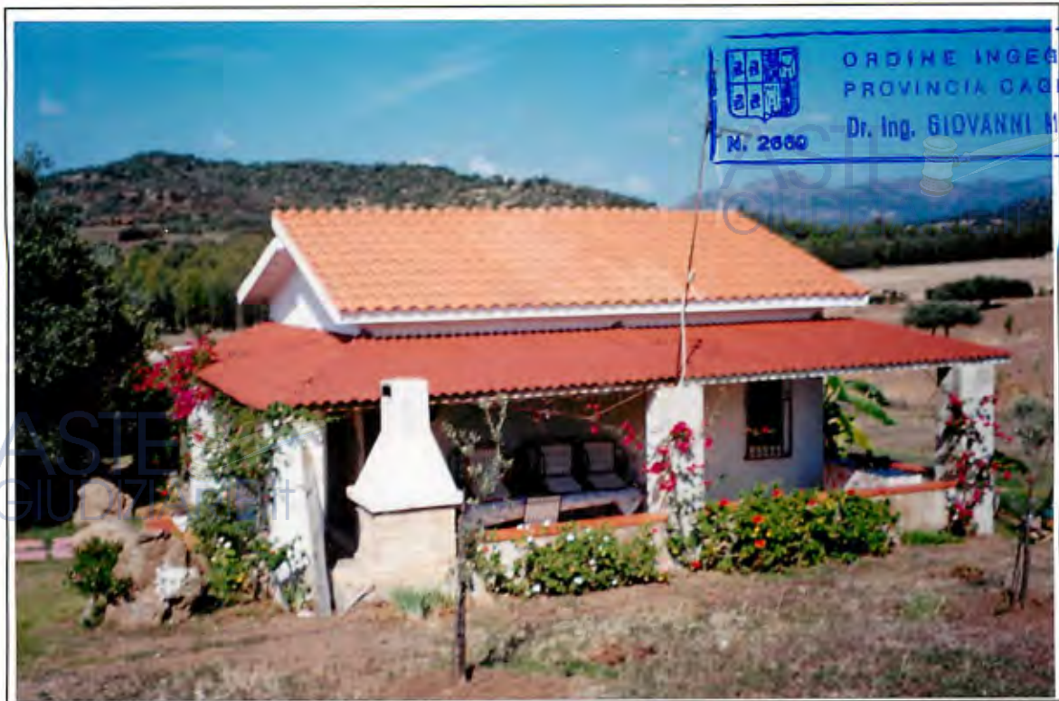
Foto - 1: Costruzione rurale - prospetto principale.
