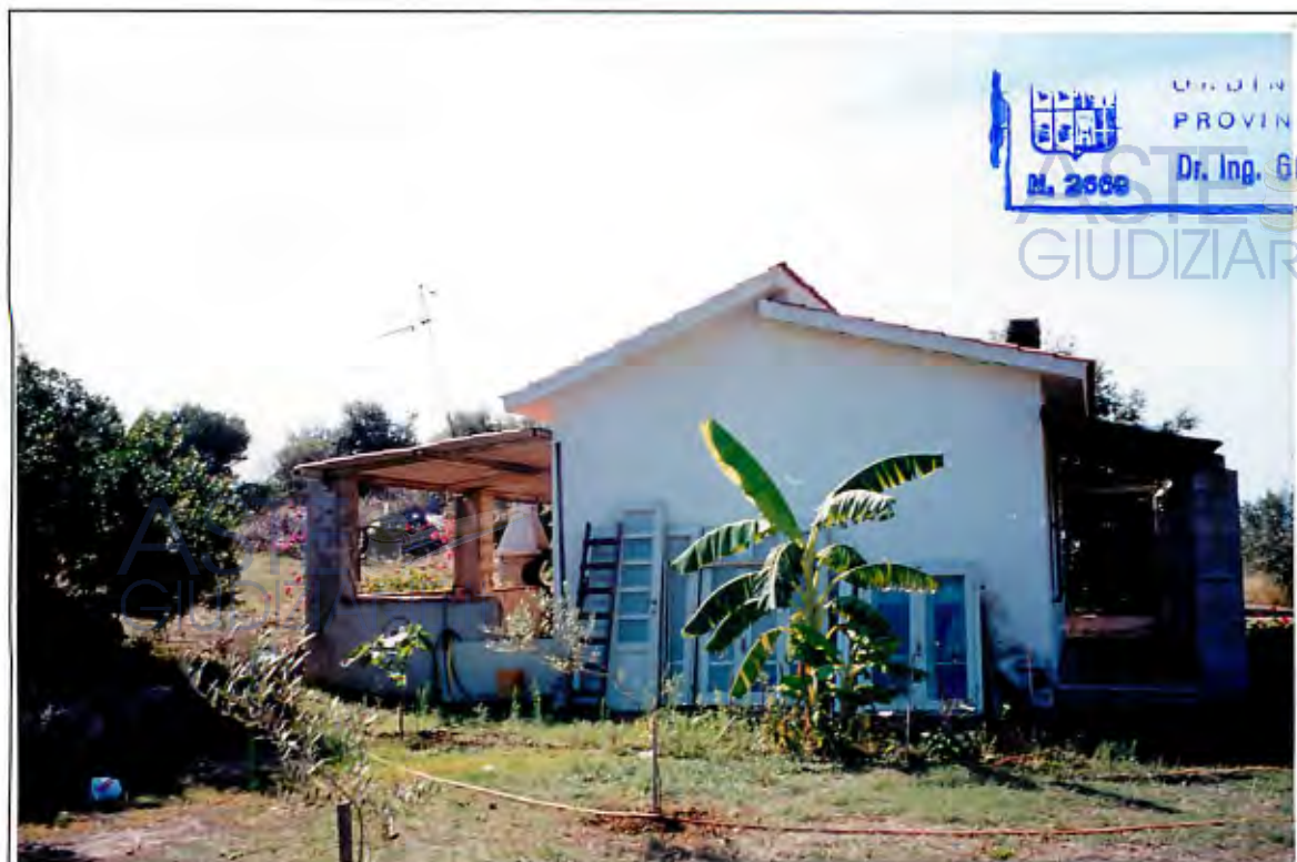
Foto - 3: Costruzione rurale – retro della costruzione, privo di loggiato.
