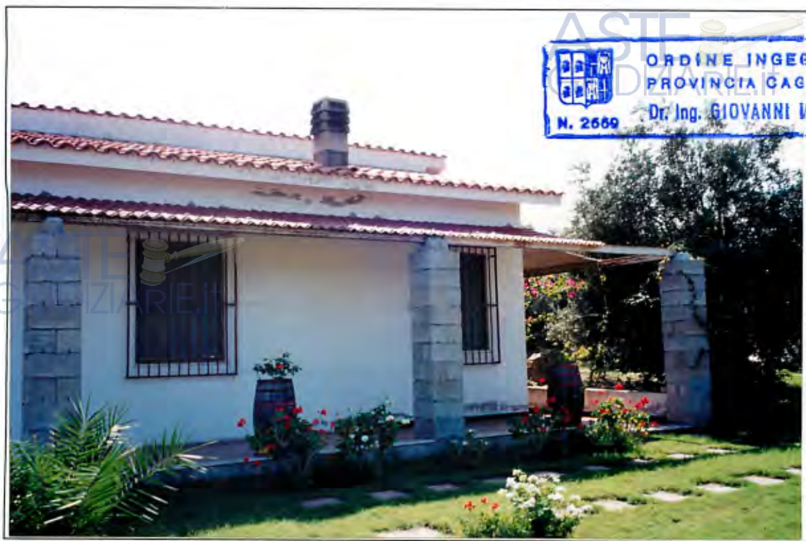
Foto - 5: Costruzione rurale: Attuale stato del loggiato in corrispondenza di un suo prospetto laterale.
