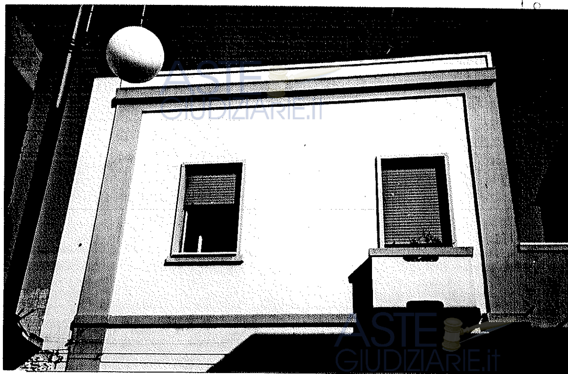
Foto - 4: Prospetto principale - civico 98 - piano primo
