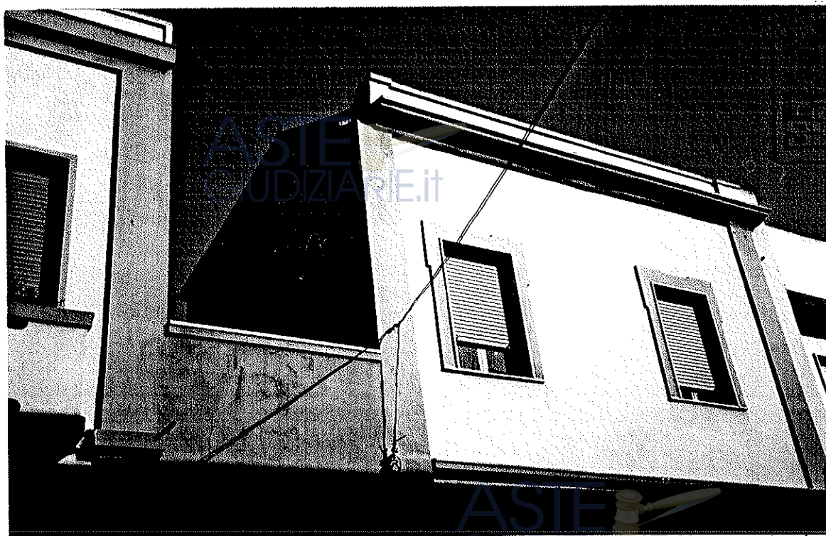
Foto - 2: Prospetto principale - civico 94 - piano primo
