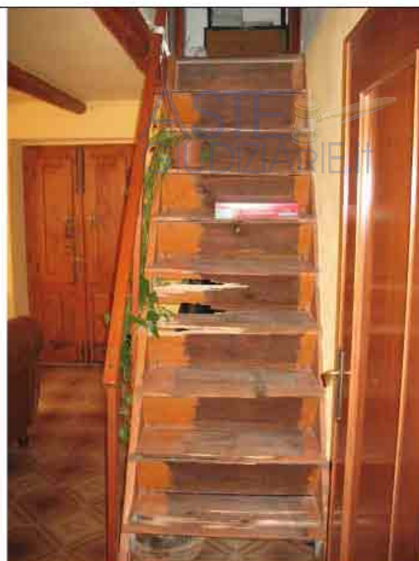
Foto n° 22 - VISTA SCALA ACCESSO PARTE VECCHIA
