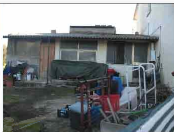
Foto n° 12 - VISTA SGOMBERO E MAGAZZINO 1
