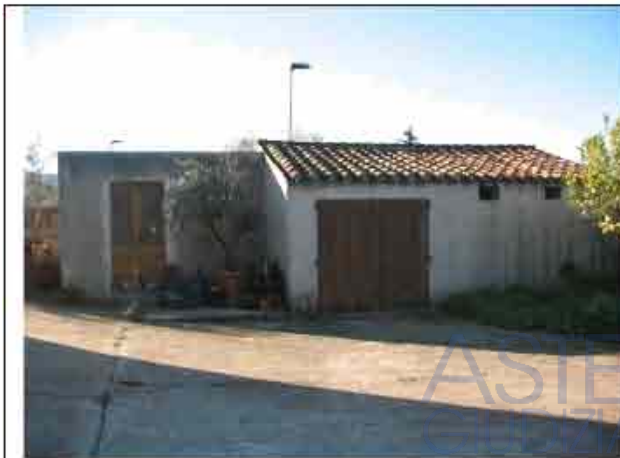
Foto n° 3 - VISTA LOCALE GARAGE E MAGAZZINO
