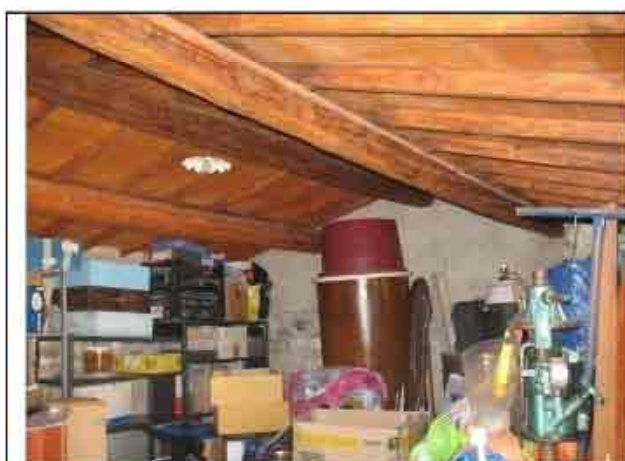
Foto n° 13 - VISTA INTERNO GARAGE
