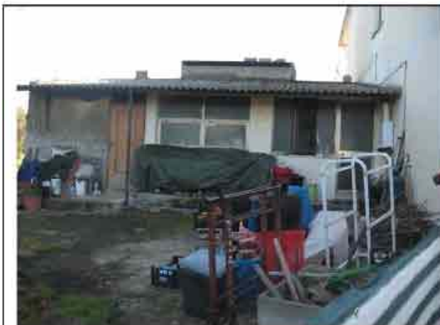
Foto n° 5 - VISTA LOCALE SGOMBERO E MAGAZZINO
