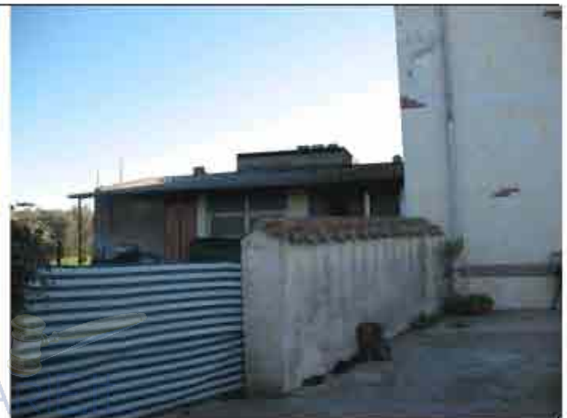
Foto n° 4 - VISTA LOCALE SGOMBERO
