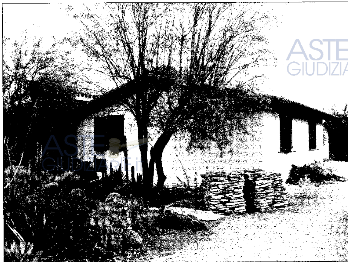
Foto 31: Scorcio dei prospetti sud e ovest della parte ampliata nel 2006.
