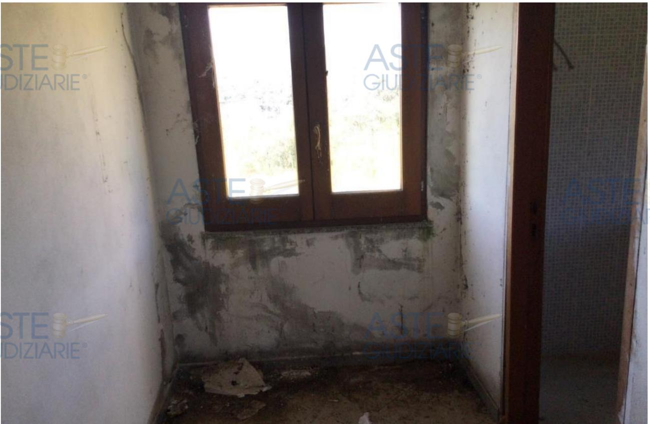
*Infisso del disimpegno e presenza di infiltrazioni dal prospetto*
