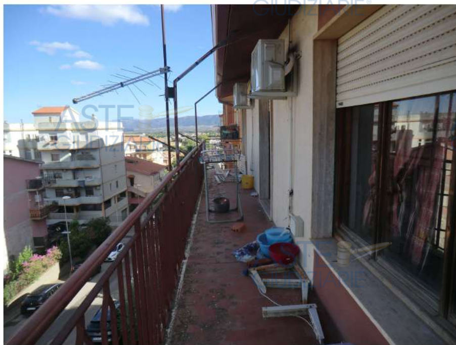
Foto n.19. Via Marmilla n.6- Iglesias. Balcone lato via Mandrolisai.
