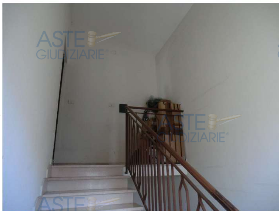
Foto n.26. Via Marmilla n.6- Iglesias. Vano scala. Accesso all'immobile pignorato. Non è presente il ripostiglio condominiale indicato nel progetto C.E. n.283/1981.
