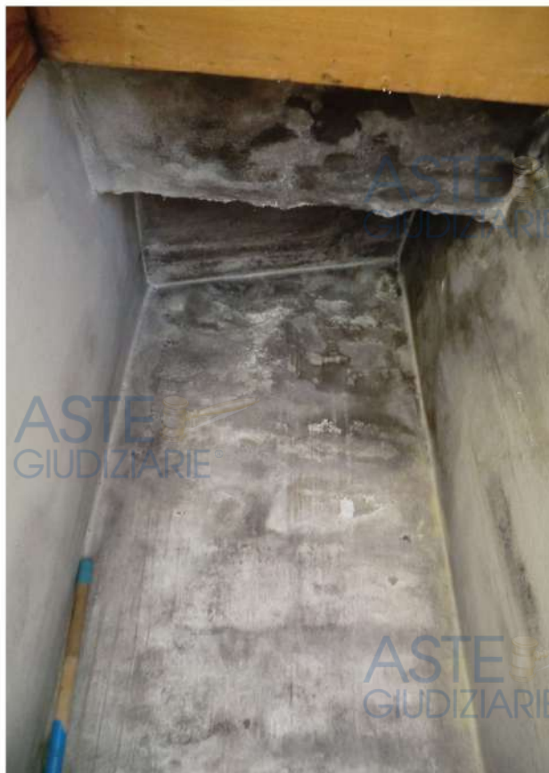
Foto n.21. Via Marmilla n.6- Iglesias. Vano dispensa. Lato interno con accesso dalla cucina.
