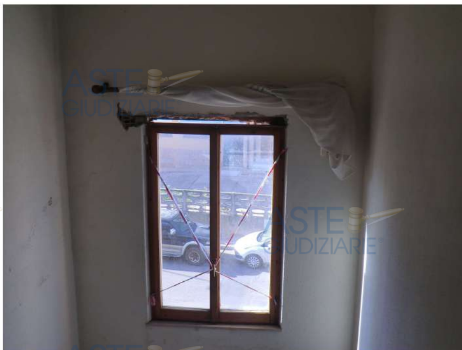
Foto n.24. Via Marmilla n.6- Iglesias. Vano scala. Infisso esterno secondo piano.
