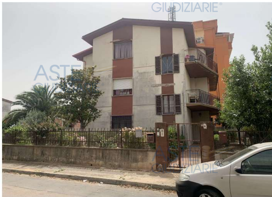
Foto n.2. Via Marmilla n.6- Iglesias. Prospetto principale.
