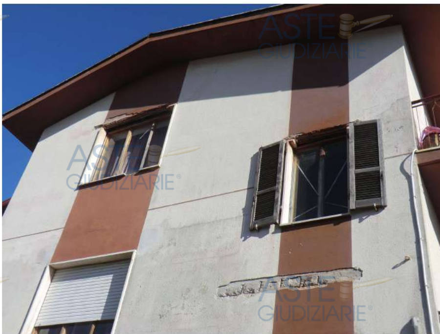
Foto n.25. Via Marmilla n.6- Iglesias. Vano scala. Infisso esterno secondo piano e architrave finestra piano secondo mansardato.
