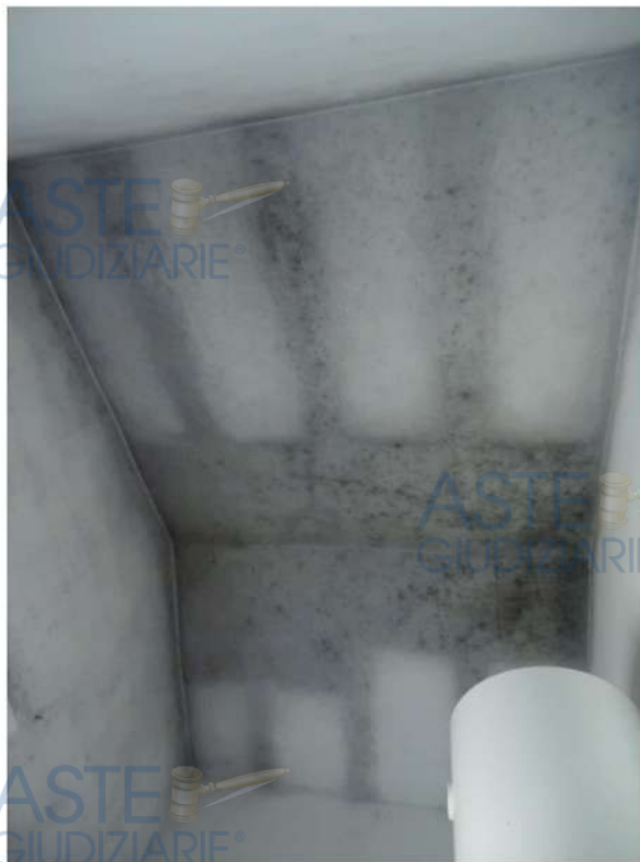
Foto n.16. Via Marmilla n.6- Iglesias. Bagno con doccia/lavanderia
