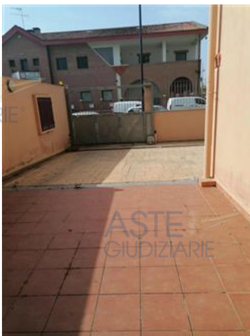
CORTILE ANTISTANTE IL PALAZZO-PASO CARRAIO DA VIA LUSSU 153
