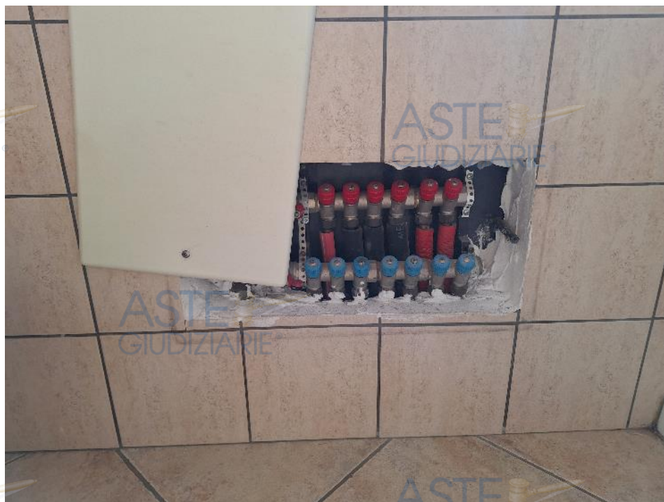
Foto 22. Bagno (particolare del collettore complanare dell'impianto idrico sanitario)
