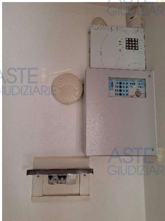
Foto 23. Soggiorno - Particolare del quadro elettrico e della centralina antifurto
