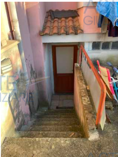
VANO SCALA INGRESSO CANTINA
