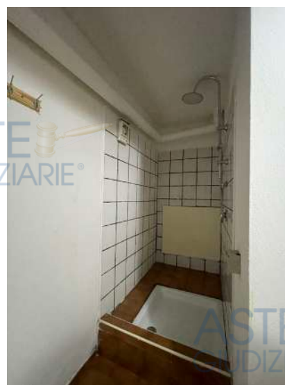
PIATTO DOCCIA REALIZZATO NEL CAVEDIO
