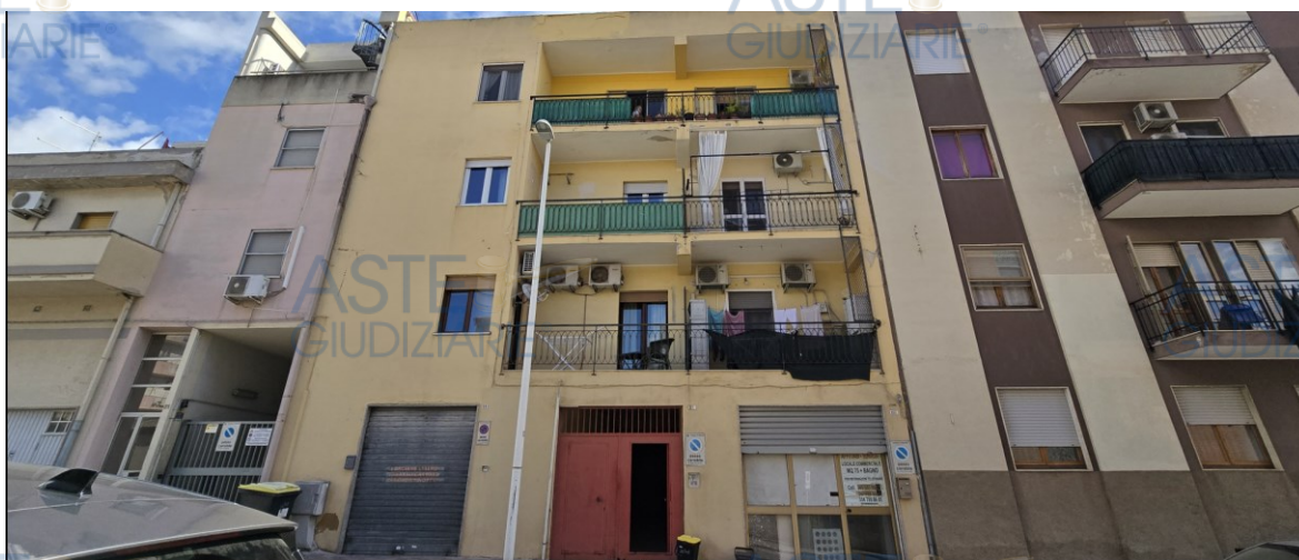
Figura 10 – Vista esterna dell'unità immobiliare oggetto di pignoramento – fronte stradale
