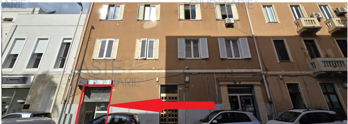
Figura 5 – Vista esterna dell'unità immobiliare oggetto di pignoramento – fronte stradale
