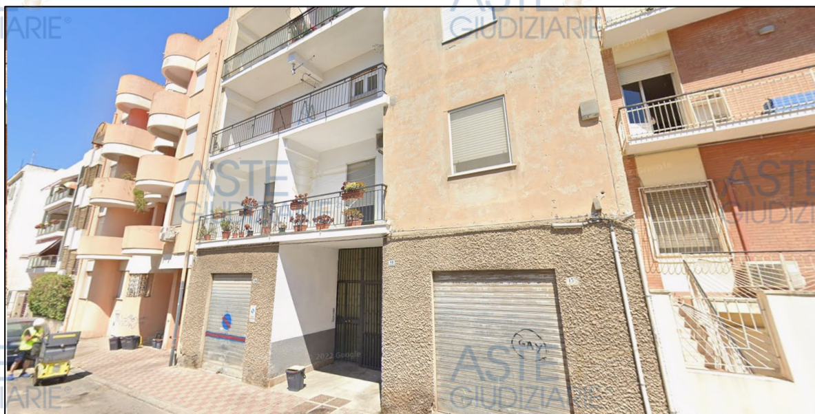
Figura 14 - Vista esterna dell'unità immobiliare oggetto di pignoramento - fronte stradale
