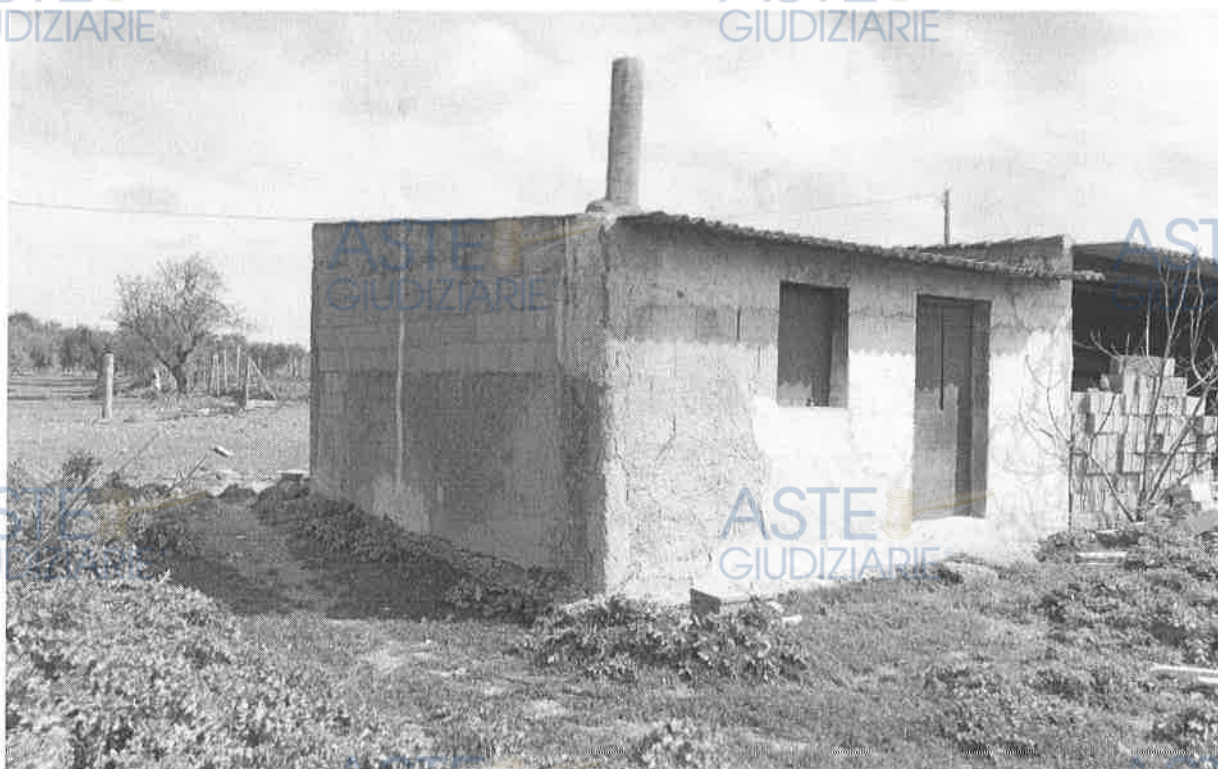
Foto 12 – Dettaglio della porzione chiusa della costruzione A ( locale deposito).
