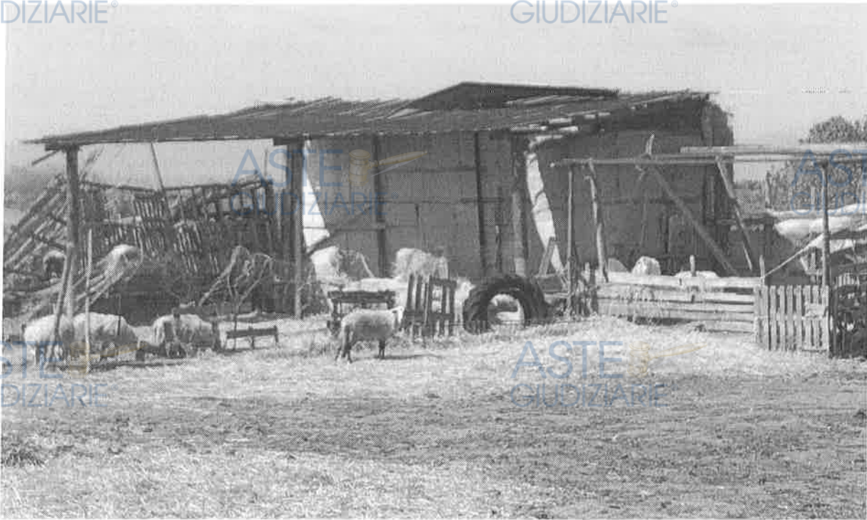
Foto 19 – Tettoia B edificata sul mappale 1 del compendio 3
