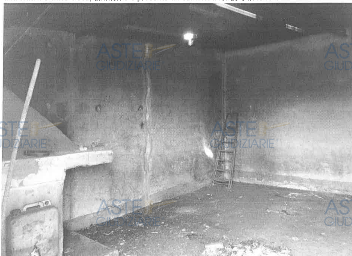
Foto 13 – Interno del corpo chiuso della costruzione A
