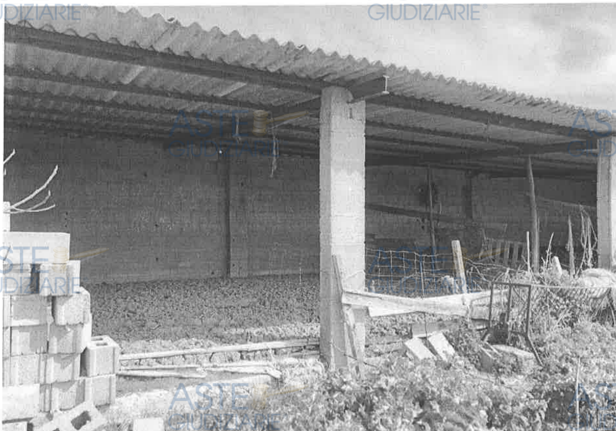
Foto 14 – dettaglio delle parti aperte del fabbricato
