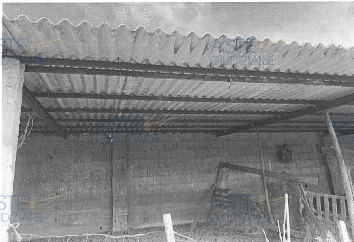
Foto 15 – Dettaglio della copertura
